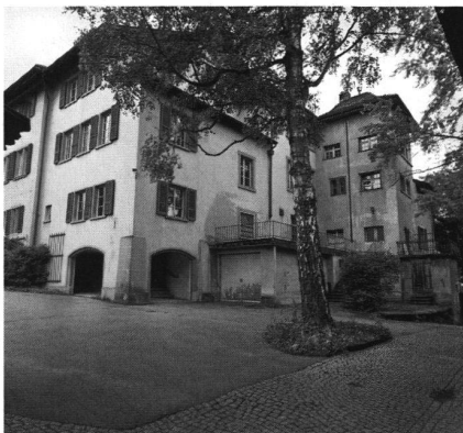
12: Nordfassade der Kernanlage mit Abortturm 1999. Er entstand in seiner heutigen Form im späten 19. Jahrhundert; er wurde dabei gegenüber seinem Vorgänger um rund 2 m zurückgenommen. Der eingeschossige Anbau auf der Nordseite zeigt in etwa seine ursprüngliche Grundrissausbildung nach Norden.
