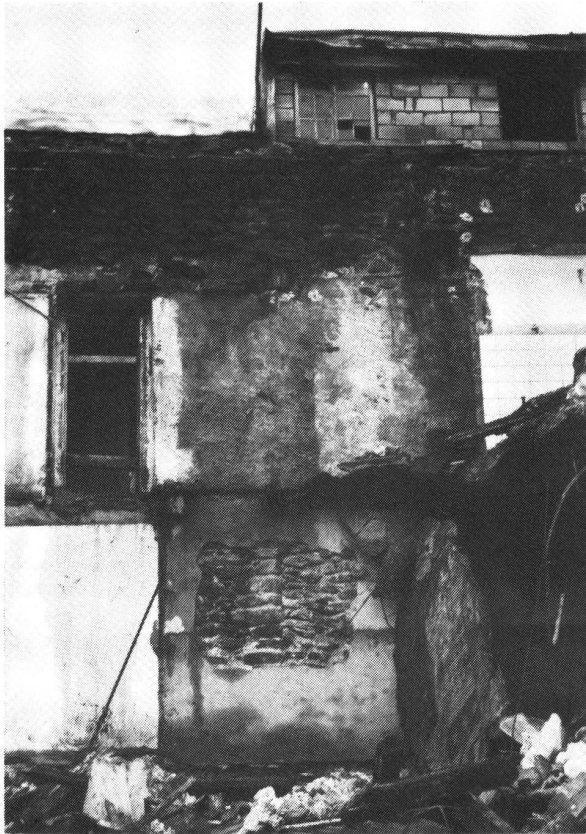
Salzhof in Brig VS. NE-Ecke des Turmes mit Anschluss an Mauer M 18. Ansicht von E.
