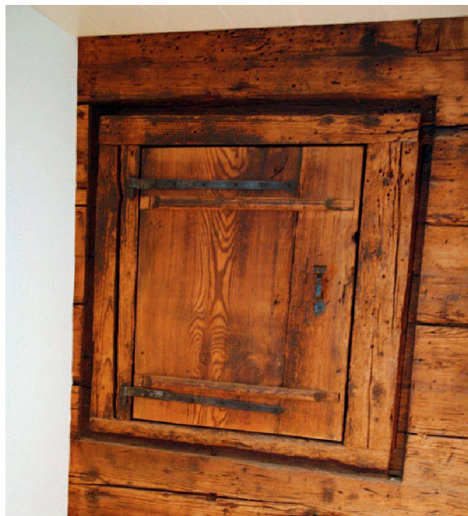
Abb. 4: In der volkstümlichen Überlieferung haben sich die Geschichten um die sogenannten «Pestfenster» erhalten, durch welche die an der Pest Erkrankten angeblich mit Nahrungsmitteln versorgt wurden. Diese Vorstellung muss als weitgehende Fiktion betrachtet werden, welche im Laufe der Zeit entstanden ist. Tatsächlich handelt es sich bei diesen «Pestfenstern» um Reste ehemaliger Wandschränke, welche herausgebrochen wurden. Das Beispiel stammt aus Steinen, Räbengasse 17.
