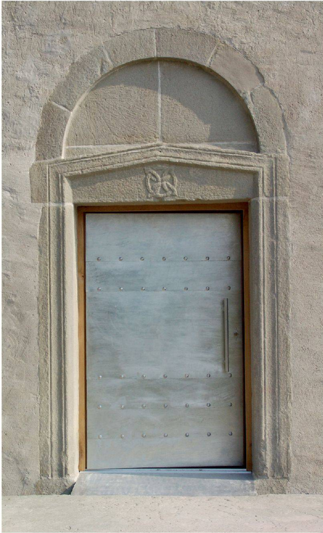
Abb. 26: Freienbach, Kirche St. Peter und Paul auf der Ufnau. Das Hauptportal stammt vermutlich von der Vorgängerkirche. Neu ist das mit verzinnnten Kupferplatten beschlagene Türblatt.
