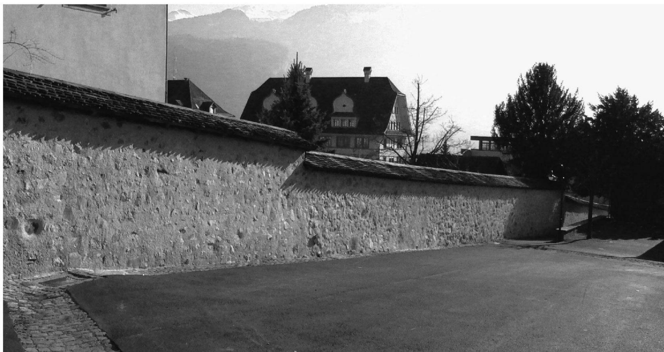
Abb. 15: Schwyz, Kapuzinerkloster. Die westseitige Einfassungsmauer des Kapuzinergartens wurde in der Technik von Schwyzer Gartenmauern mit partiell sichtbaren Steinköpfen restauriert.
