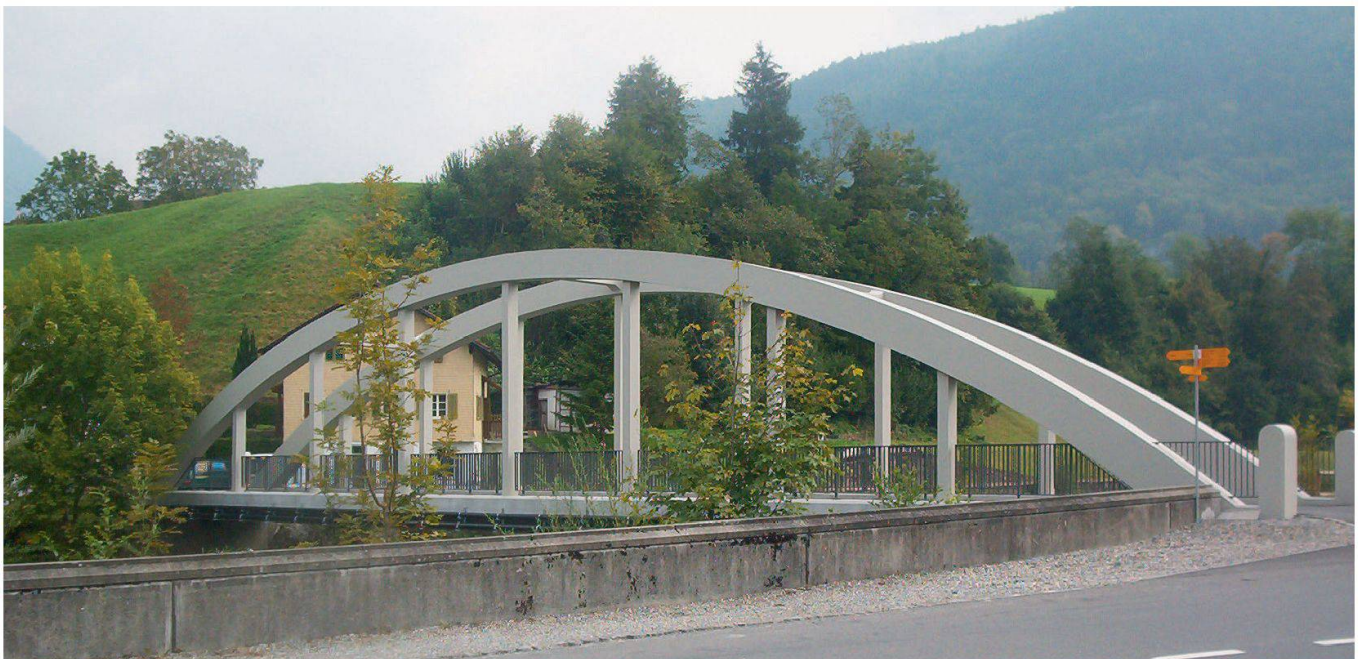
Abb. 10: Schwyz, Brücke Hinteribach. Die restaurierte Betonbogenbrücke, von Westen gesehen.
