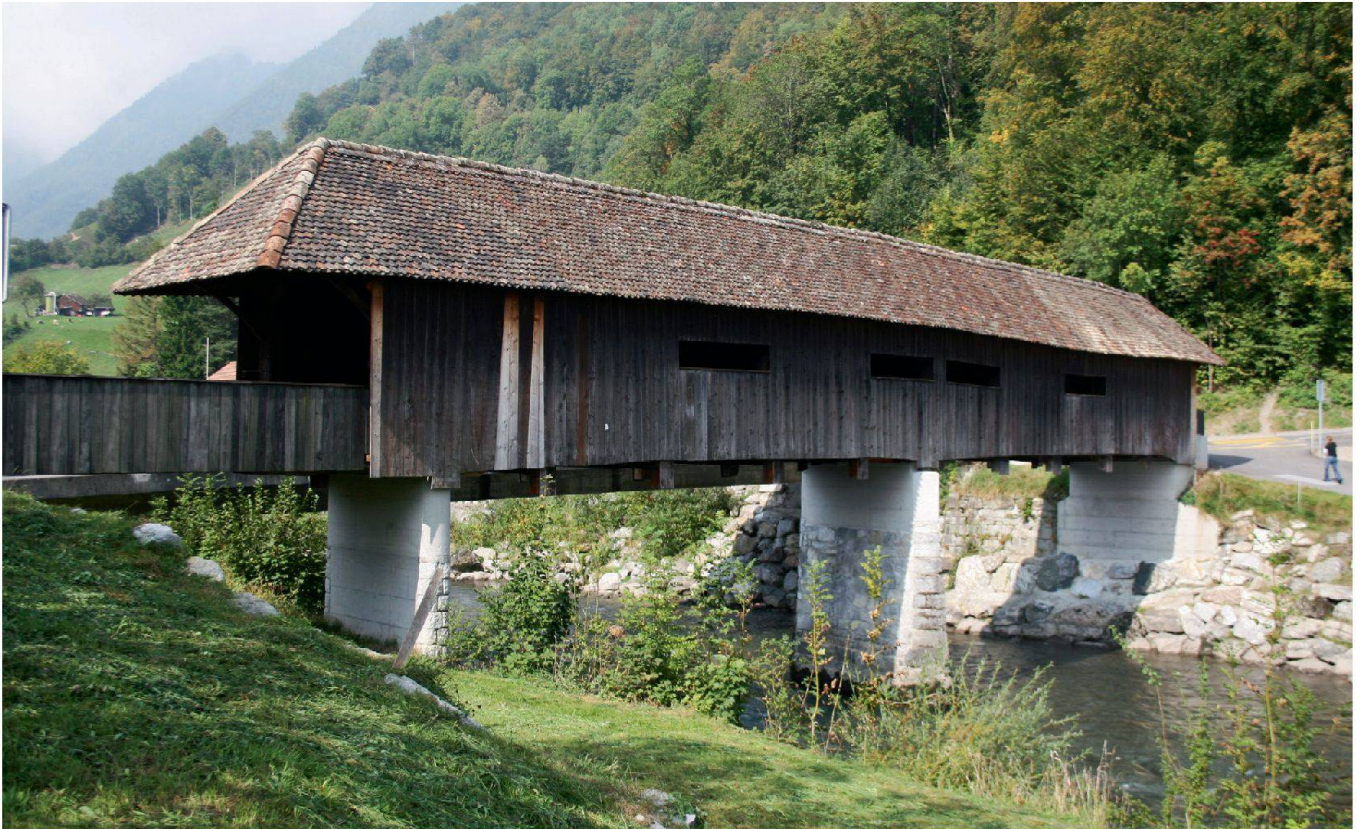
Abb. 16: Ingenbohl, Wylbrücke. Die Brücke präsentiert sich nach dem Anheben um zirka einen Meter wesentlich besser und hat durch diese Massnahme an Dominanz gegenüber der neuen Wylbrücke gewonnen.
