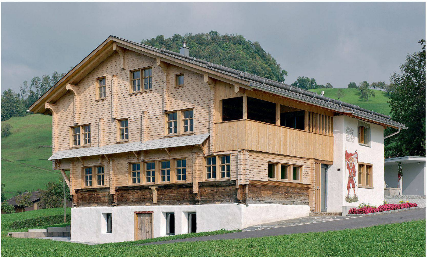
Abb. 3: Schwyz, Haus Engiberg 8, Seewen (Köplihaus). Am markanten Gebäude lassen sich zwei Hausteile ablesen. Der bergseitige Teil ist massiv gemauert und verputzt, der talseitige als Holzstrick ausgeführt. Auf dem verputzten Teil ist in Anlehnung an eine alte Zeichnung die Darstellung des Erbauers des Hauses als Söldnerführer aufgemalt.
