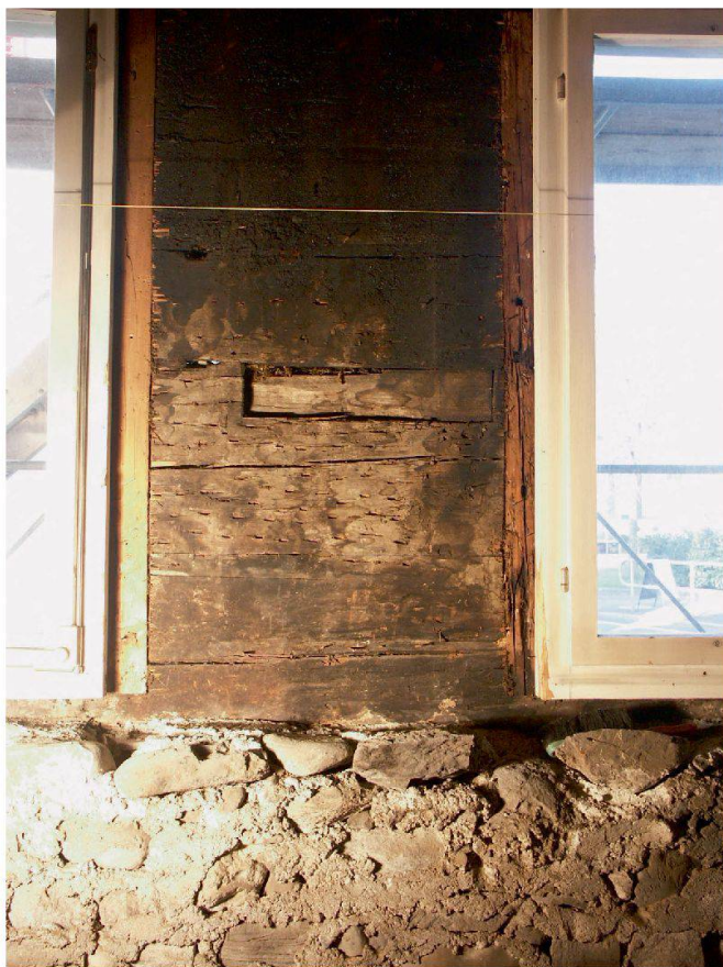
Abb. 6: Westwand der offenen Rauchküche (1.5), originaler Fensterschlitz.
