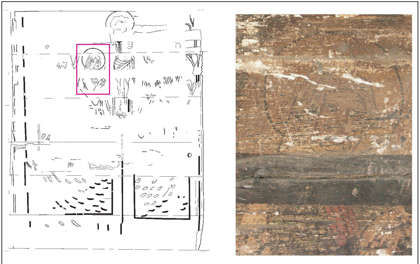
Abb. 17: Südwand der Stube (1.2), Fragmente einer Kreuzigungsgruppe, erste Hälfte des 16. Jahrhunderts, Umzeichnung und Detailaufnahme.
