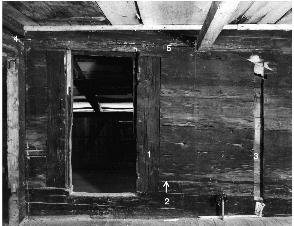
Abb. 21: Südwand des Ganges (2.1). 1: Türpfosten; 2: eingeschnittener Block; 3: Nut zur Aufnahme der ehemaligen Ostwand der Kammer (2.5); 4: Decken-Boden-Bohlen; 5: Negativ der Decken-Boden-Bohlen.
