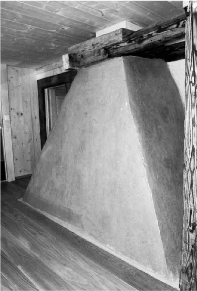
Abb. 14: Reichenburg, Haus Oberbürgeli. Der Rauchfang, der als unten offener Rutenkamin ausgebildet ist, beansprucht einen wesentlichen Teil des vorhandenen Platzes im oberen Gang.
