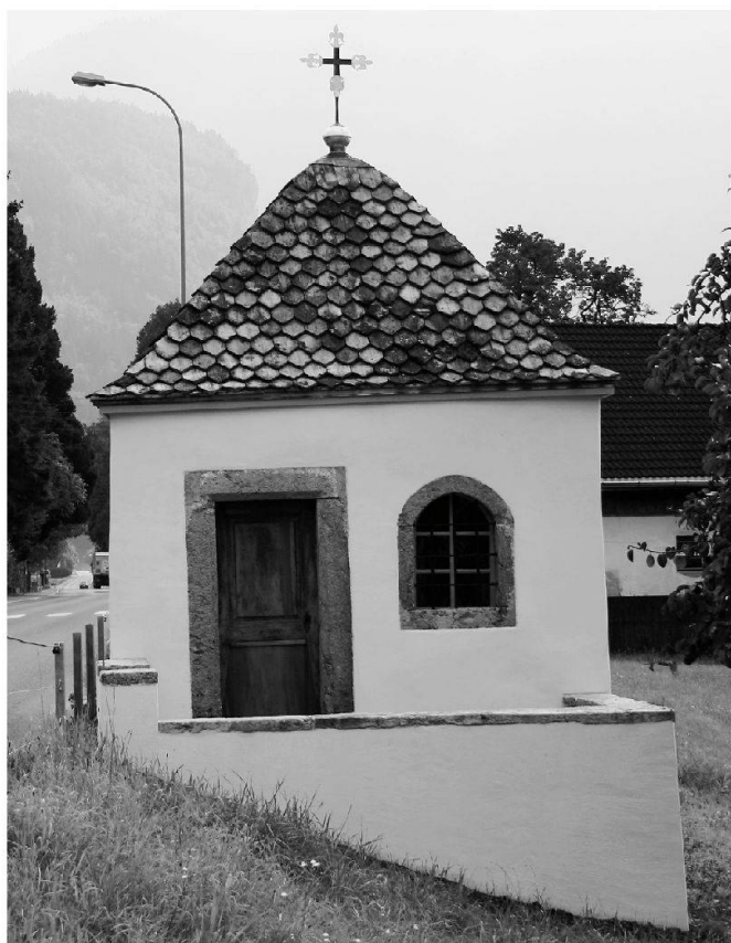
Abb. 1: Schwyz, Abegg-Kapelle. Die vermutlich erst im 19. Jahrhundert eingerichtete Kapelle war ursprünglich als ein für Schwyzer Gärten typisches Schattenhäuschen erbaut worden. Dessen Pendant wurde im Zusammenhang mit dem Bau der Muotathalerstrasse abgebrochen.
