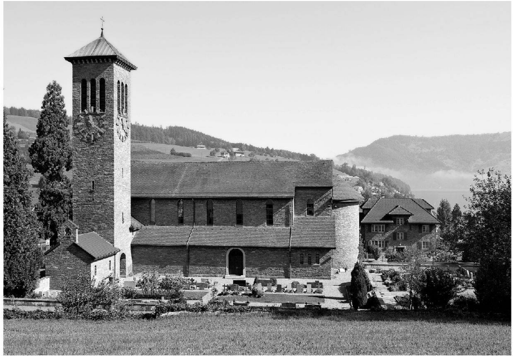
Abb. 15: Küssnacht, Pfarrkirche St. Sebastian, Immensee. Kirche, Totenkapelle, Pfarrhaus mit Unterrichtszimmer und Friedhof bilden eine für die Zwischenkriegszeit typische Anlage mit sichtbelassenem Bruchsteinmauerwerk aus Tessiner Granit.
