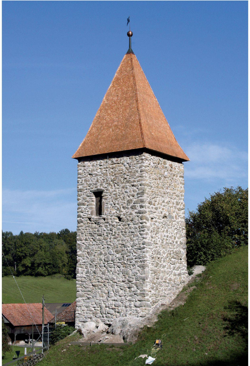
Abb. 5: Sattel, Letztiturm. Die Restaurierungsarbeiten am Turm beschränkten sich auf konservierende Massnahmen an Dach und Mauerwerk.
