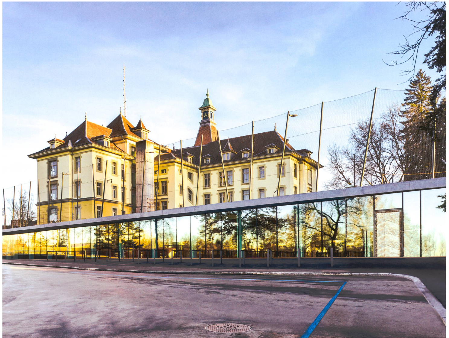
Doppeltturnhalle Bitzium, Bern. Doppeltturnhalle unter Turn- und Pausenplatz in direkter Verbindung zum Schulgebäude. wbachitekten GmbH, Bern. Foto Alexander Gempeler
