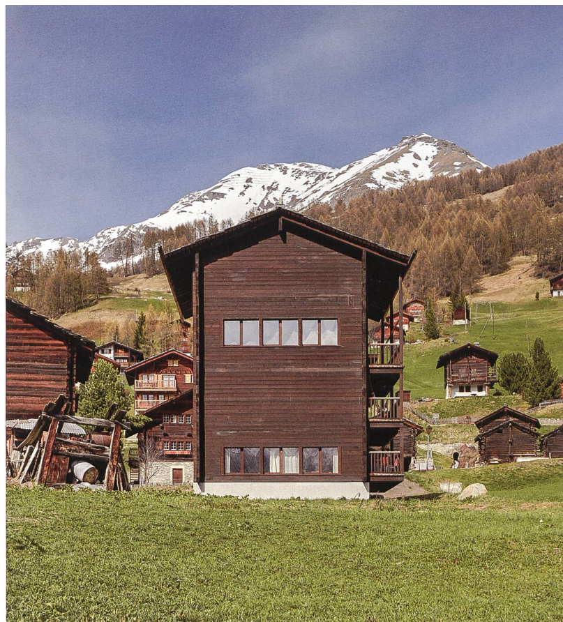
Fig. 10 Face sud-ouest. Aux angles, des fausses-coches imitent les tsavaches traditionnelles, découlant de la technique constructive du Blockbau , soit l'empilement de madriers à mi-bois. La façade est ouverte par deux bandeaux de fenêtres aux niveaux 1 et 3, correspondant aux pièces à vivre, et « fermée » aux niveaux des chambres à coucher, qui privilégient des baies latérales. © Dirk Weiss, 2018
