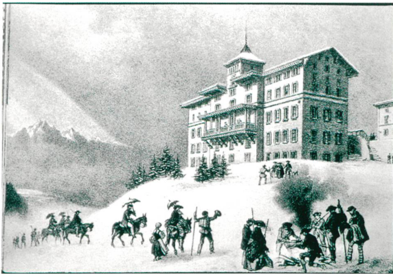
Abb. 7 Das 1857 eröffnete «Hotel Regina Montium» von Architekt Ferdinand Stadler auf Rigi-Kulm. Lithografie von 1858. (aus: Flückiger-Seiler 2001, Abb. 170)
