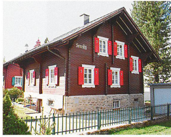
Chalet Sunneschy: 1932/33 erbaut durch Baumeister Gisler, Altdorf, für einen «Fortwächter» (Festungswächter). Eines von über einem Dutzend Chalets ähnlicher Bauart in Andermatt.
