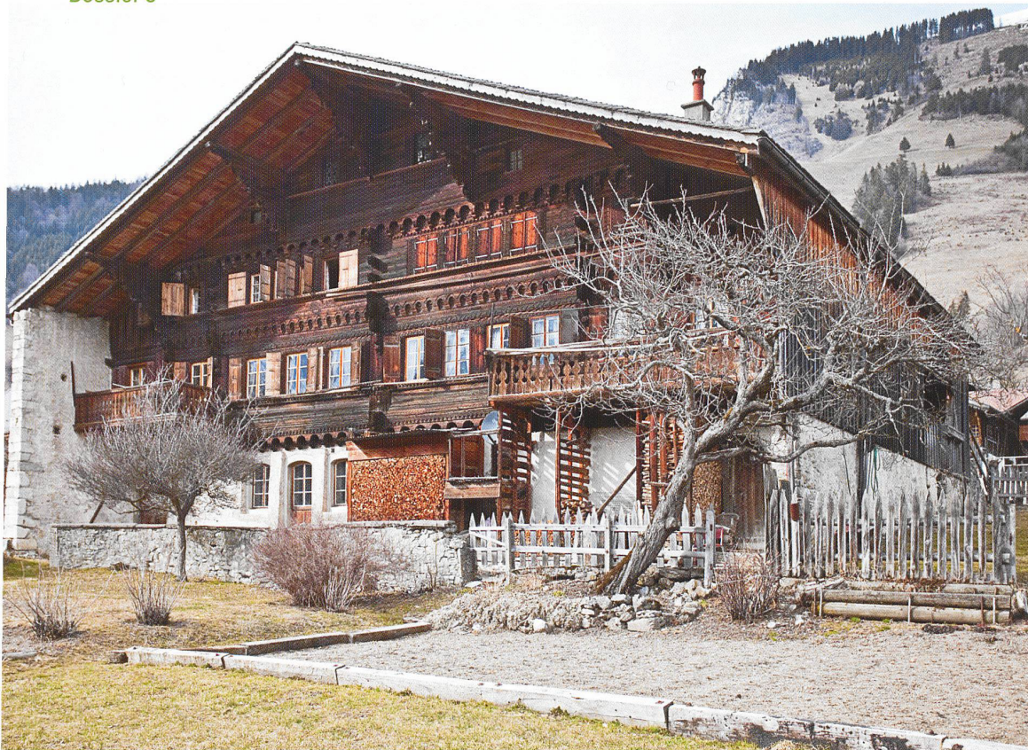
Rossinière: La Maison de la Place, 1664
