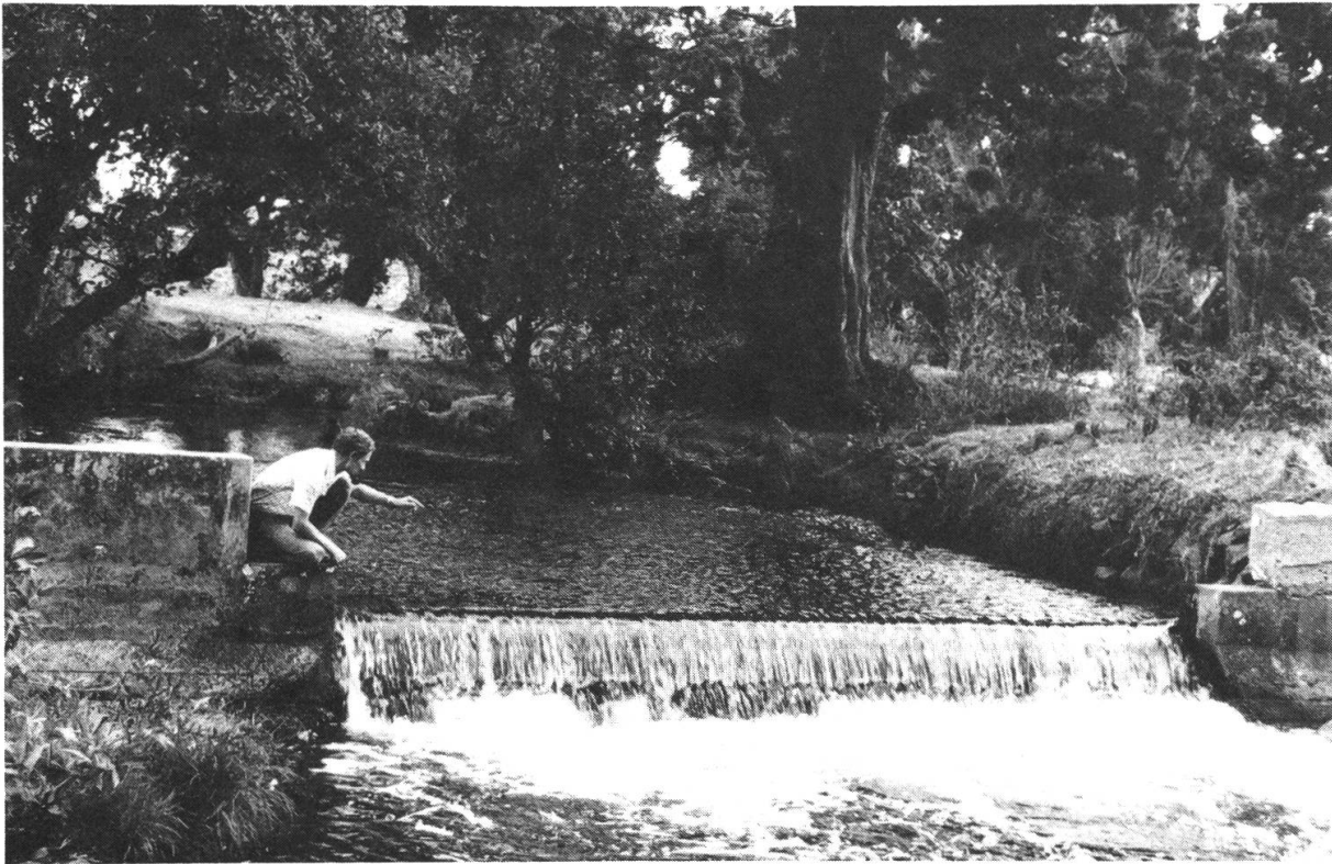
Abbildung 6: Die Messstelle Naro Moru-River 5 BC 2 gehört zum permanenten Abflussmessnetz. Sie ist ausgebaut als Rechteck-Wehrüberfall mit Lattenpegel, der täglich 2 mal abgelesen wird. Aufnahme Trockenzeit August 1979.
