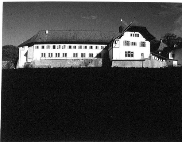
Fig. 55. Fribourg FR, Abbaye de la Maigrauge. Façades sud de l'aile orientale et de l'aile méridionale après restauration en 2013. Photo SAEF, G. Bourgaral.
