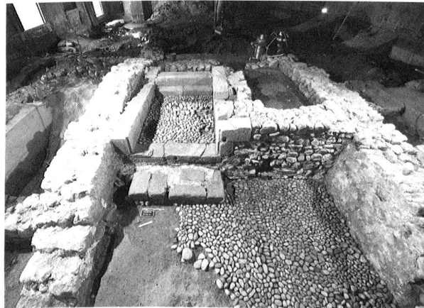
Fig. 41. Genève GE, Rue de la Rôtisserie. Le chantier de l'Alhambra en début de campagne : vestiges des maisons médiévales, aménagements médiévaux et modernes de la cour intérieure d'un immeuble. Photo SCA GE, Ph. Ruffieux.
