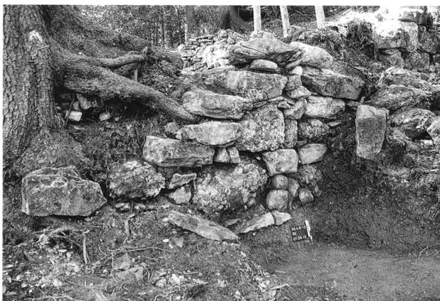
Abb. 46. Sattel SZ, Morgarten, Letzimauer. Gut erhaltene feindseitige Mauerfront am westlichen Ende der Letzimauer. Foto J. Obrecht.
