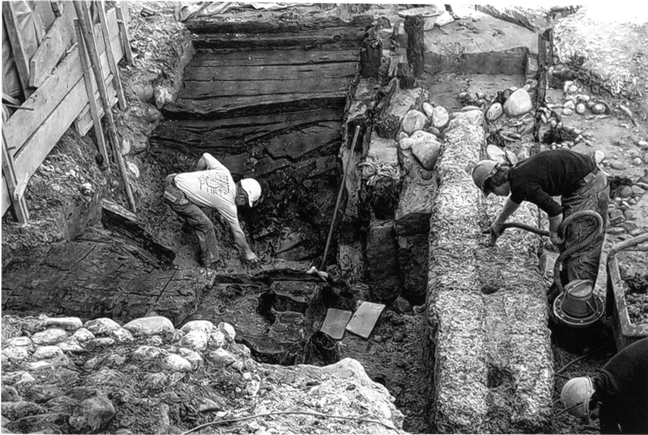
Abb. 18. Baden AG, Bäderquartier, Limmatknie. Verstärkte Holzkonstruktion, die eine geologische Störung überbrückte, und ihre seitliche Schalung. Foto KA AG.
