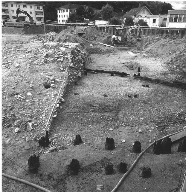
Abb. 19. Studen BE, Wydenpark. Im Vordergrund Pfähle des Brückensjochs. Links der geschnittene Damm mit Widerlager. In der Bildmitte und rechts Reste von Rutengeflecht und Hölzer der Widerlager- und Dammverankerung. Blick nach Westen. Foto ADB.
