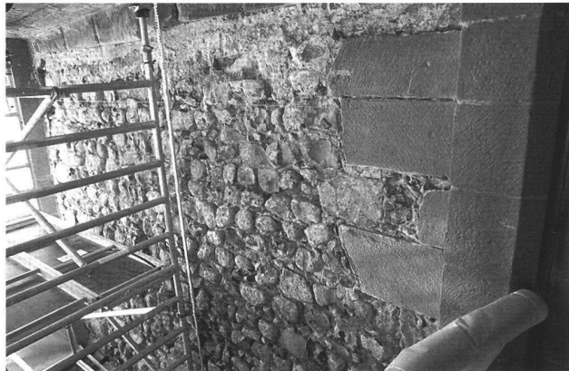
Abb. 53. Zug ZG, Kolinplatz 12, Zitturm. Blick von der Altstadt in die Tordurchfahrt Richtung Norden. Das äusserst regelmässige, originale Mauerwerk der Zeit um 1300 ist brandversehrt. Die Sandsteinquader vorne links bilden den inneren Torbogen und stammen von 1480. Foto KA ZG, M. Bolli.
