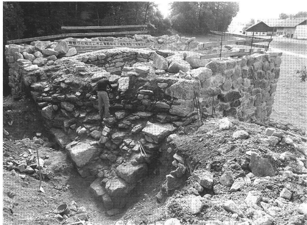
Abb. 44. Bossonnens FR, Château. In Vorbereitung von Konsolidierungsarbeiten freigelegte Nordwestecke des Bergfrieds mit quer verlaufender Trockenmauer aus kleineren Bruchsteinen. Foto AA FR, Ch. Kündig.
