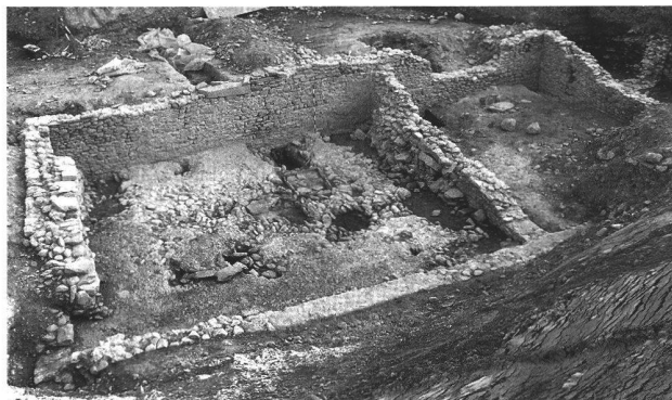
Fig. 33. Saillon VS, Les Proz. Vue générale du corps de bâtiment romain appartenant à la villa gallo-romaine. Vue depuis le sud. Photo TERA Sàrl.
