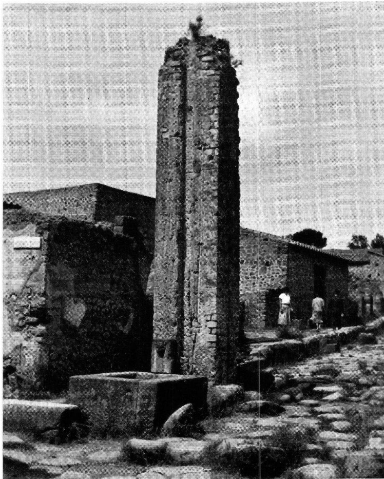
Tafel 9 B. Pompeji, kleiner Wasserturm zur Druckreduzierung ( S. 61 ).
