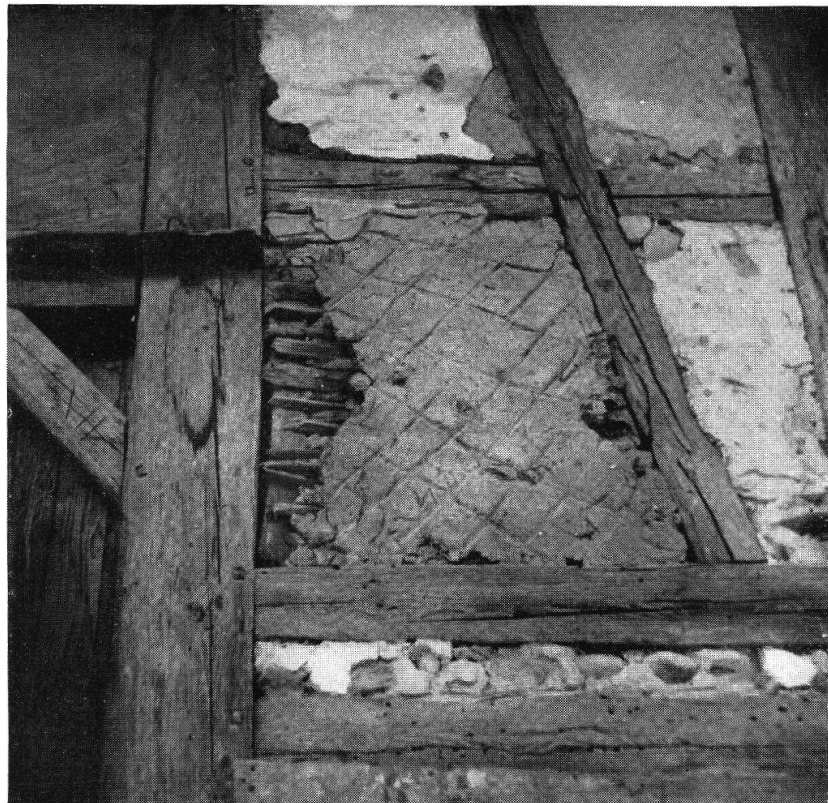
Taf. XI, Abb. 2. Endingen. Fachwerk an heute noch bestehendem Haus zu Vindonissa (S. 65)
