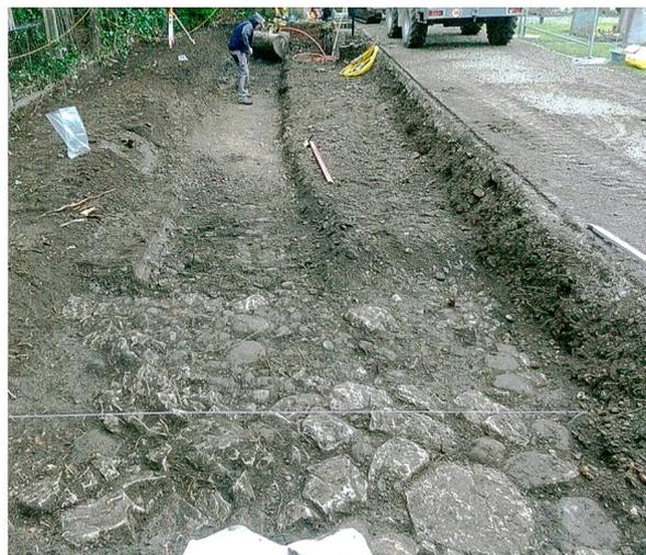
Abb. 6: Kaiseraugst AG, Neubau Urnenwand (Grabung 2014.002). Strassenunterbau aus Kalksteinplatten an MR 1 und MR 2; im oberen Bildbereich der helle, ältere Strassenkörper. Blick von Norden.
