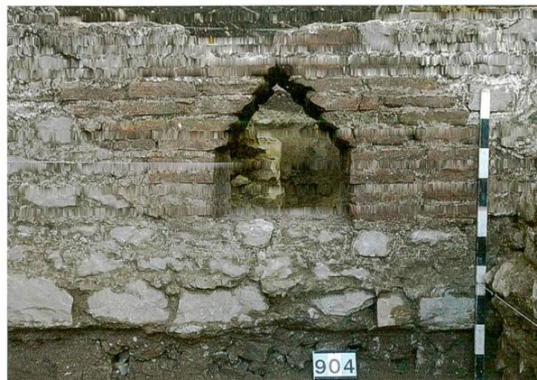
Abb. 47: Kaiseraugst AG, Umbau Dorfstrasse 29 (Grabung 2014.008). Die sehr sorgfältig ausgeführte Öffnung MR 54 unbekannter Funktion. Schön zu sehen ist, wie die Abbruchkante der mittelkaiserzeitlichen MR 60 zur Öffnung hin immer tiefer liegt. Die mit Ziegelplatten gebaute Öffnung MR 54 wurde gleichzeitig mit der spätantiken MR 42 errichtet. Blick von Norden.
