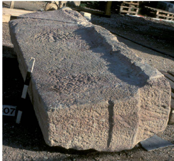
Abb. 14: Augst, Theatersanierung (Grabung 2007.055). Dokumentation der Werksteinstücke; Keilstein (Schlussstein) eines Bogens der nördlichen Eingangshalle, grobkörniger Buntsandstein. Ansicht mit Stirnseite und sorgfältig geglätteter Lagerfläche; im oberen Bereich (rechts im Bild) vorstehende Bosse, die zusammen mit der grob belassenen Oberseite belegt, dass der Bogen in eine Mauer aus opus-vittatum-Mauerwerk eingefügt war.
