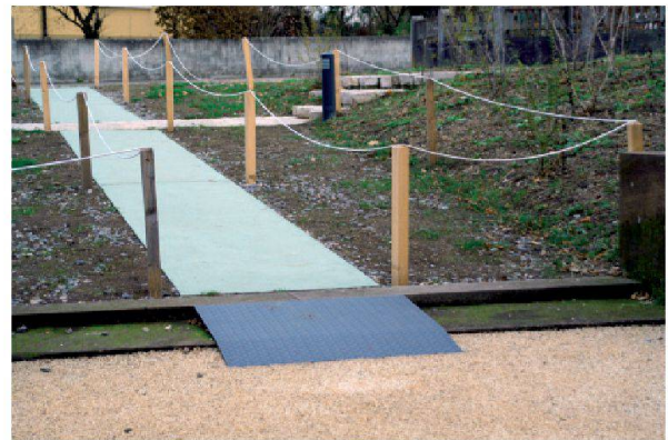
Abb. 26: Augst, Theatersanierung (Grabung 2007.055). Behindertengerechter Zugang zum Mittelvomitorium, Blick von Westen. Der Falz in der Sandsteinschwelle zum Vomitorium wird durch ein Rampenstück aus Riffelblech überbrückt.
