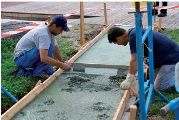
Abb. 25: Augst, Theatersanierung (Grabung 2007.055). Behindertengerechter Zugang zur Orchestra, Blick von Nordwesten. Rampe in grünlich eingefärbtem Beton, Mitarbeiter der Fa. M. Fux AG während der Ausführung.
