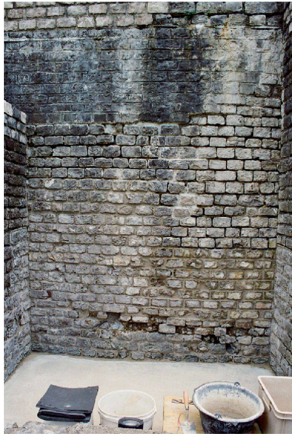
Abb. 28: Augst, Theatersanierung (Grabung 2007.055). Feinsanierung der Mauerschale von MR 55 mit stark durchfeuchtetem Mauerfuss im Bereich zwischen MR 155 und MR 156. Aufnahme nach Abschluss der Maueranierung, vor dem Einbringen der schützenden Kiesanfüllung. Blick von Norden.
