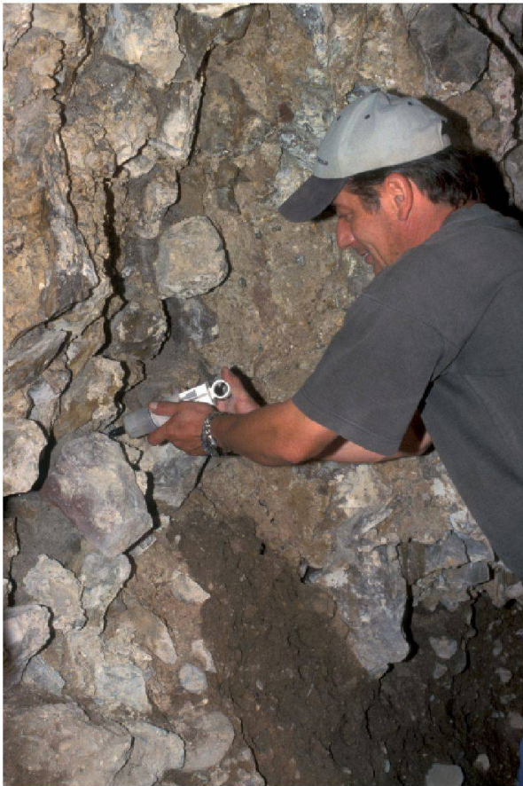
Abb. 27: Augst, Theatersanierung (Grabung 2007.055). Sanierung des Versturzpfeils über den Sandsteinfundamenten der nördlichen Eingangshalle des Theaters. Mladen Puklin, Mitarbeiter der Firma Fux AG, festigt das aufgelockerte Mörtelmaterial durch Applikation einer Kalkemulsion.
