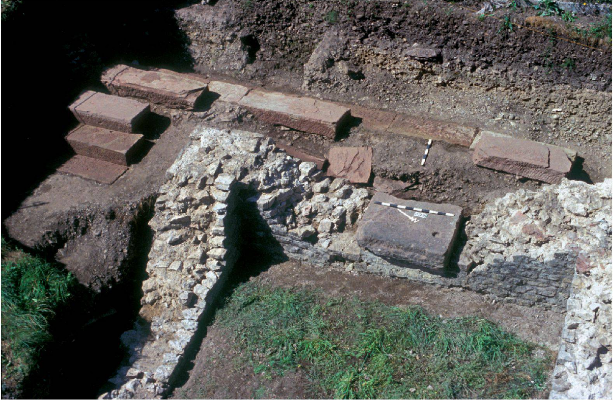
Abb. 5: Augst, Theatersanierung (Grabung 2007.055). Zone westlich des Westcarcers; die Treppenkonstruktion aus Buntsandstein aus der Zeit vor dem älteren szenischen Theater wird vom Westcarcer des Amphitheaters (Mauerzüge im Vordergrund) durchschlagen. Blick von Nordosten.
