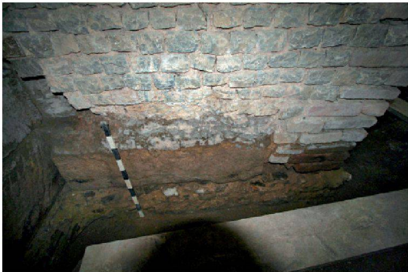
Abb. 10: Augst, Theatersanierung (Grabung 2007.055). Bauabklärung an den Stützpfeilern der nördlichen Eingangshalle; Blick von Nordwesten an den Stützpfeiler MR 188. Links im Bild die Sandsteinquader einer älteren Bau-phase, im Zentrum und rechts das Kalksteinmauerwerk der jüngsten Pfeiler-phase respektive einer späteren Verstärkung des Pfeilers.
