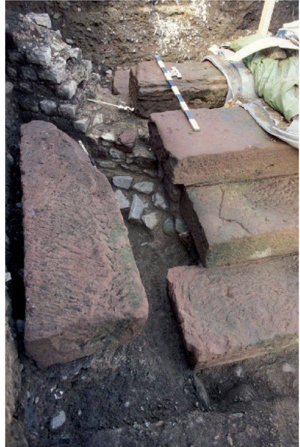
Abb. 8: Augst, Theatersanierung (Grabung 2007.055). Zone westlich des Westcarcers; rechts im Bild die Ostseite der Sandsteintreppe aus der Zeit vor dem älteren szenischen Theater, links ein Stufenquader, der vermutlich vom obersten, bereits in der Antike entfernten Tritt stammt (vgl. auch den Falz am westlichen obersten Quader, unterhalb der Fotonummer). Deutlich erkennbar ist, wie die ältere partiell ausgebrochene Mauer unter dem eingesetzten Treppenlauf durchzieht. Man beachte, dass der Treppenfuss im Osten und Westen auf demselben Niveau liegt, der Treppenlauf also nicht zur Überwindung eines Höhenunterschieds diente, sondern als rein architektonisches Gestaltungselement zu verstehen ist. Blick von Nordosten.
