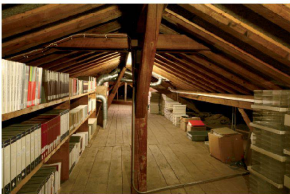
Abb. 12: Augst, Museum Augusta Raurica. Der unbeheizte Teil des Römerhaus-Dachbodens dient behelfsmässig als Lagerraum für Verpackungsmaterial, Bücher und Modelle (Tab. 1,13).
