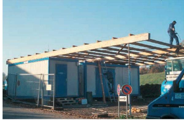
Abb. 55: Augst, Theatersanierung (Grabung 2005.055). Erstellen der redimensionierten, provisorischen Baustelleneinrichtung für die im Jahr 2006 verbleibenden Arbeiten; Aufbau von Büro- und Mannschaftscontainer auf dem Gelände jenseits der modernen Sichelstrasse.
