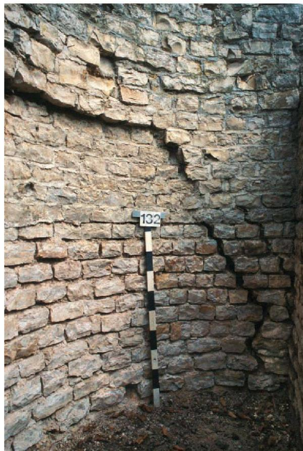
Abb. 38: Augst, Theatersanierung (Grabung 2005.055). Peripherie, Keil 4. Entlastungsbogen MR 140 mit leicht verschobenem, originale Kalksteinmauerwerk und statisch bedingter Rissbildung in der Mauerschale.
