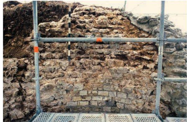
Abb. 40: Augst, Theatersanierung (Grabung 2005.055). Peripherie, Keil 4. Entlastungsbogen MR 138 mit freiliegendem, von Frost und Erosion stark in Mitleidenschaft gezogenem Mauerwerkern.
