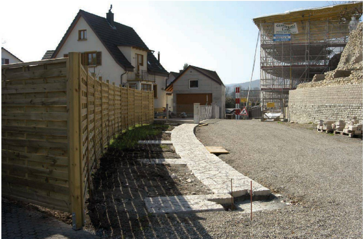
Abb. 67: Augst, Augusta Raurica, Theatersanierung. Rechts das letzte grosse Baugerüst der mehrjährigen Konservierungsarbeiten, von welchem aus die Mauerarbeiten an der Peripherie von Keil 4 ausgeführt werden konnten. Im Vordergrund ist der Grundriss des Ersten Theaters im Boden markiert, hier konkret die Peripheriemauer mit kleinen Strebepfeilern in kurzen Abständen. Links im Bild die neu erstellte Sichtschutzwand gegen einen Privatgarten. Dank der Grundeigentümerin, der Stiftung Pro Augusta Raurica, konnte die alte Hecke mit Gartenmauer über dem Theaterbefund entfernt und der neue Zaun einige Meter innerhalb der Parzelle errichtet werden. So haben die Besucher ein einprägsames Gesamtbild vom Grundriss des ältesten Theaters von Augusta Raurica.
