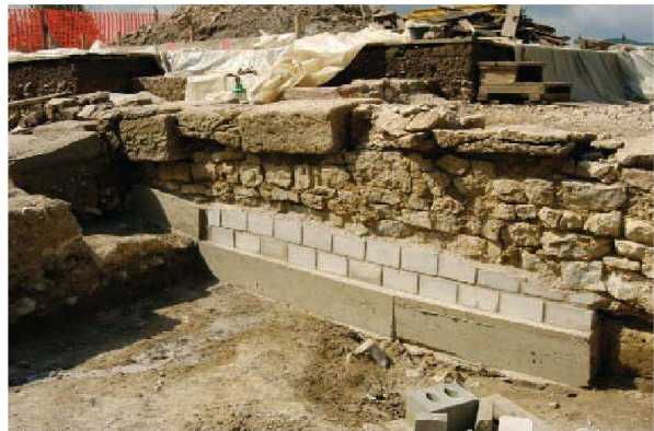
Abb. 63: Augst, Augusta Raurica, Insula 27. Die mit einem Betonfundament und modernen Zementbacksteinen unterfangene Mauer 11 (Abb. 62). Nach Wiederherstellung des Gehniveaus des 3. Jahrhunderts n. Chr. sind nur noch die einst überirdischen «aufgehenden» Mauerteile mit den imposanten Schwellsteinen sichtbar.
