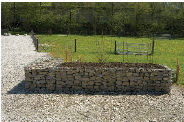
Abb. 68: Von der Ideenskizze bis zum Prototyp: Muster für eine Markierungsmöglichkeit römischer Mauerfluchten zur Veranschaulichung antiker Baufluchten im Freilichtmuseum. Drahtgitterkörbe sind mit Bruchsteinen (analog den römischen Mauern, aber ohne Mörtel) und mit einer dünnen Betondeckung oder Wurzelsperrefolie ausgekleidet. In der Mitte sind sie mit Erde gefüllt und mit winterharten einheimischen Kleingehölzen bepflanzt. Die Konstruktion erfüllt sowohl die didaktisch angestrebte Assoziation «römische Mauer» bzw. «Bauflucht» als auch den Schutz der ungestörten Kulturschichten vor unerwünschter Durchwurzelung und Auslaugung (das Anpflanzen von Hecken und Alleen zur Markierung antiker Bebauungslinien bzw. Strassenfluchten hingegen wäre ein grosses konservatorisches Risiko für die Fundschichten).
