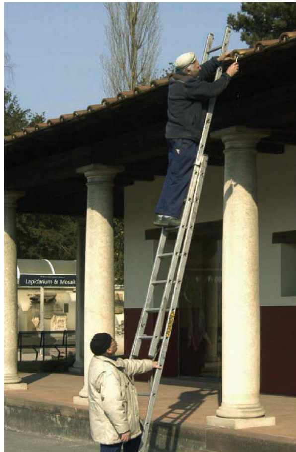
Abb. 69: Augst, Augusta Raurica. Am Römerhausdach müssen im Rahmen des normalen Unterhalts – aber in antiker Weise – die Hohlräume zwischen den untersten Leisten- und Holzriegeln mit Kalkmörtel ausgefügt werden.
