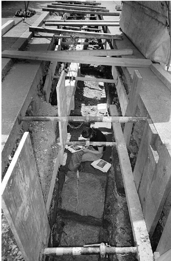
Abb. 6: Augst BL, Wasserleitung Giebenacherstrasse (Grabung 2003.51). Spriessungen, ein schmaler Graben, eine schleifend geschmittenen Mauer und irgendwo zwischendrin die Archäologin (Barbara Pfäffli) am Dokumentieren – Alltag einer Leitungsgrabung.
