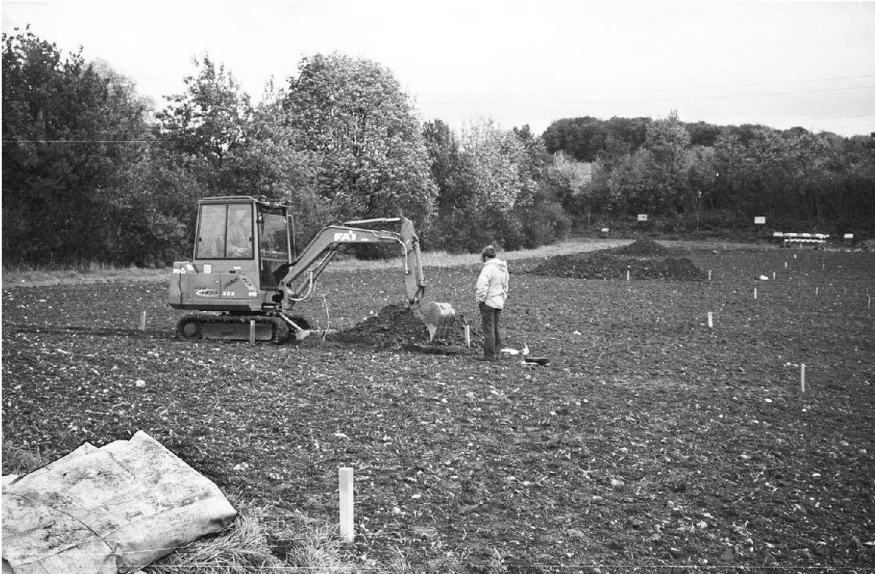
Abb. 40: Augst BL, Leitungsgraben Kellermatt (Grabung 2003.59). Im Acker nördlich der Autobahn (Parz. 1051) werden Sondiergräben angelegt, um die Verhältnisse im Bereich Steinlerstrasse und Westtorstrasse abzuklären. Die Pflöcke markieren das alte Leitungstrasse und den vermuteten Verlauf der Westkante der römischen Steinlerstrasse. Von Nordwesten.
