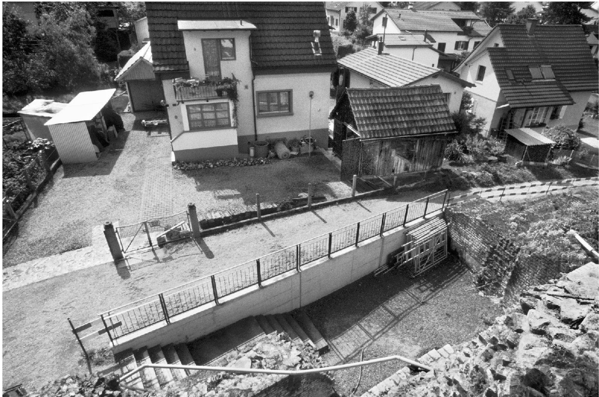
Abb. 26: Augst BL, Schmid (Grabung 2003.54). Übersicht über die dicht überbaute Parzelle 521 in unmittelbarer Nähe des römischen Theaters. Aufnahme vom Theater nach Süden. Die Umfassungsmauer des ersten Theaters ist im Bereich der Zufahrt zur Liegenschaft im Belag markiert. Der Garagenneubau wurde an Stelle des im Vordergrund sichtbaren Holzschopfs errichtet.
