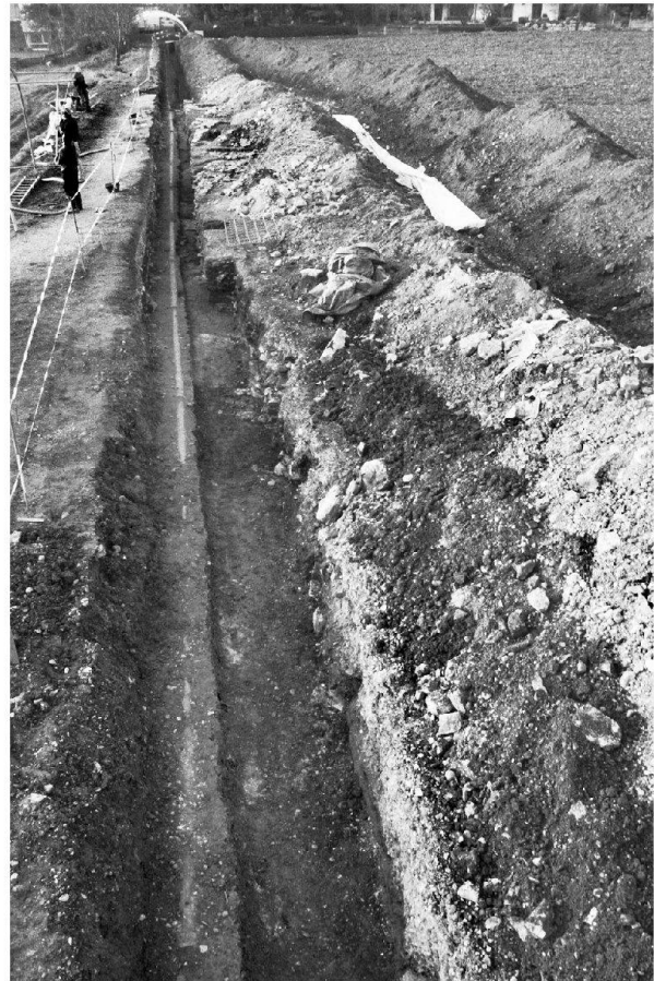
Abb. 35: Augst BL, Leitungsgraben Kellermatt (Grabung 2003.59). Nördliches Drittel des Leitungsgrabens im Überblick. Links der Abhang zum Wildental, rechts die ebene Fläche des Steinler. Von Südwesten.
