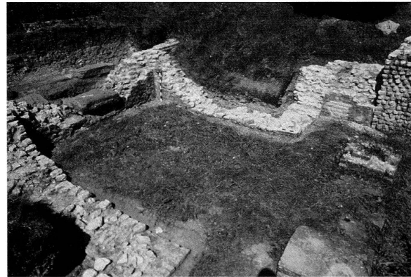
Abb. 42: Augst, Theatersanierung (Grabung 2002.55). Sanierungsarbeiten am Westcarcer des älteren Amphitheaters. Übersicht nach Entfernung der alten, stark beschädigten Zementrestaurierungen. Die antike Mauerkrone ist vollständig freigelegt, gereinigt und partiell injiziert. In einem nächsten Arbeitsschritt erfolgt das Aufbringen einer dampfdiffusionsfähigen Isolationsschicht zum Schutz vor eindringendem Meteorwasser. Nach der Ergänzung der abgebauten Mauerteile folgt als Verschleisschicht eine den antiken Mauerkern imitierende Abdeckung aus Kalksteinschroppen.
