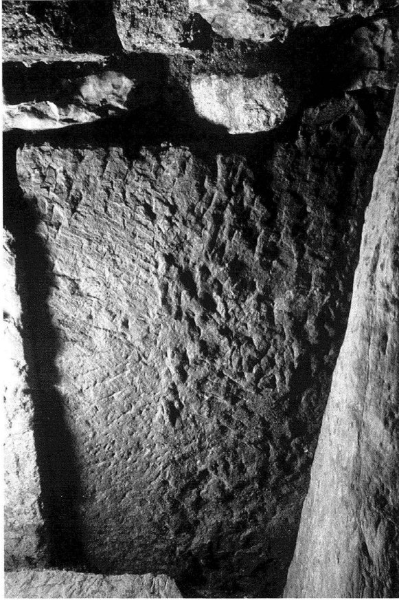
Abb. 30: Augst, Theatersanierung (Grabung 2002.55). Abwasserkanal, Verzweigung im Süden, südöstlicher Abschnitt mit Sandsteinkammer. Blick von Südwesten an die Abarbeitung an der nordöstlichen Kammerwand, die für die ältere Phase der Sandsteinkammer an dieser Stelle eine Querwand belegt.
