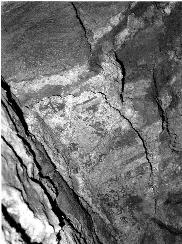
Abb. 8: Augst, Theatersanierung (Grabung 2002.55). Blendbogen der südlichen Eingangshalle. Erhalten gebliebener Verputzrest an der Innenleibung des Sandsteinbogens (zur Lage vgl. Abb. 7). Die Bemalung des Verputzes imitiert einen Werksteinbogen aus Buntsandstein, dessen Keilsteine durch rot bemalte Fugen voneinander abgesetzt sind.
