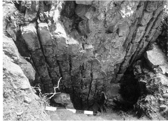
Abb. 3: Augst, Theatersanierung (Grabung 2002.55). Blendbogen der südlichen Eingangshalle. Ansicht an die im Befund untere Mauerschale des abgestürzten Mauerblocks mit Blendbogenrest und bogenförmig verlaufender Mörtelbraue. Zustand während der Freilegung.
