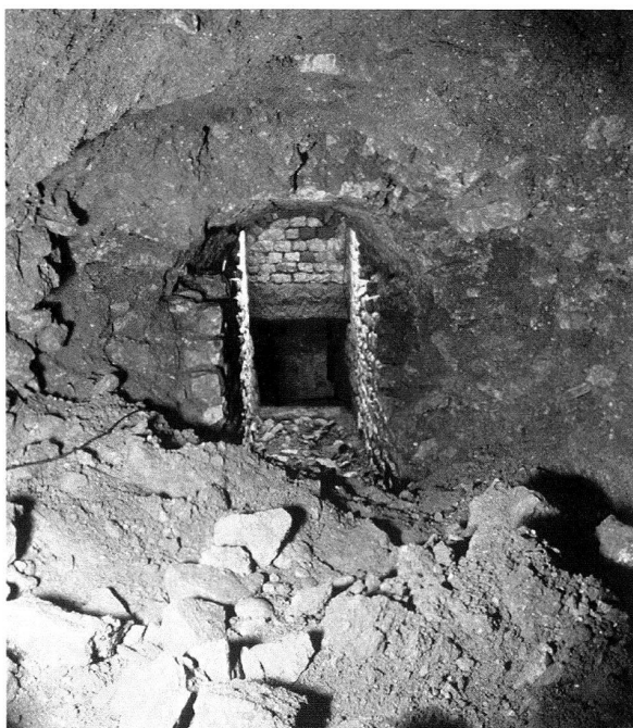
Abb. 13: Augst, Theatersanierung (Grabung 2002.55). Abwasserkanal, Verzweigung im Süden, südwestlicher Abschnitt. Blick vom südwestlichen, zerstörten Ende in Richtung Mündung. Im Vordergrund das kavernenartige Südwestende mit den ausgebrochenen Schalenquadern der Kanalwandung links im Bild. Im Zentrum der Sandsteinarchitrav hinter dem Einstiegschacht, der die Kanalhöhe im Bereich der Verzweigung auf 0,90 m reduziert (vgl. Abb. 14). Im oberen Bildteil ist der Querschnitt durch das teilweise zerstörte Kalksteingewölbe erkennbar.
