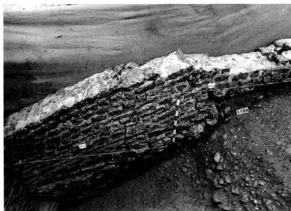
Abb. 32: Augst BL, Degen-Messerli (Grabung 2001–2002.64). Nordwand von Raum [9] (zur Lage vgl. Abb. 29). An dieser Mauer ist die Aufmauerung mittels extrem schräger Lagen von Bausteinen besonders eindrücklich. Links unten ist die Mauer in die dunkle Abfalldéonie der Holzbau-Phase(n) am Hangfuss fundamétiert. Von Süden.
