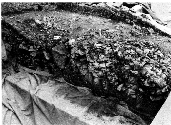
Abb. 35: Augst BL, Degen-Messerli (Grabung 2001–2002.64). Die schon teilweise abgebaute Trümmerschicht im Südteil von Raum 9 (Abb. 29). Im Profil vorne sichtbar der mittlere Buntsandsteinsockel des Raums (vgl. Abb. 34). Von Nordwesten.
