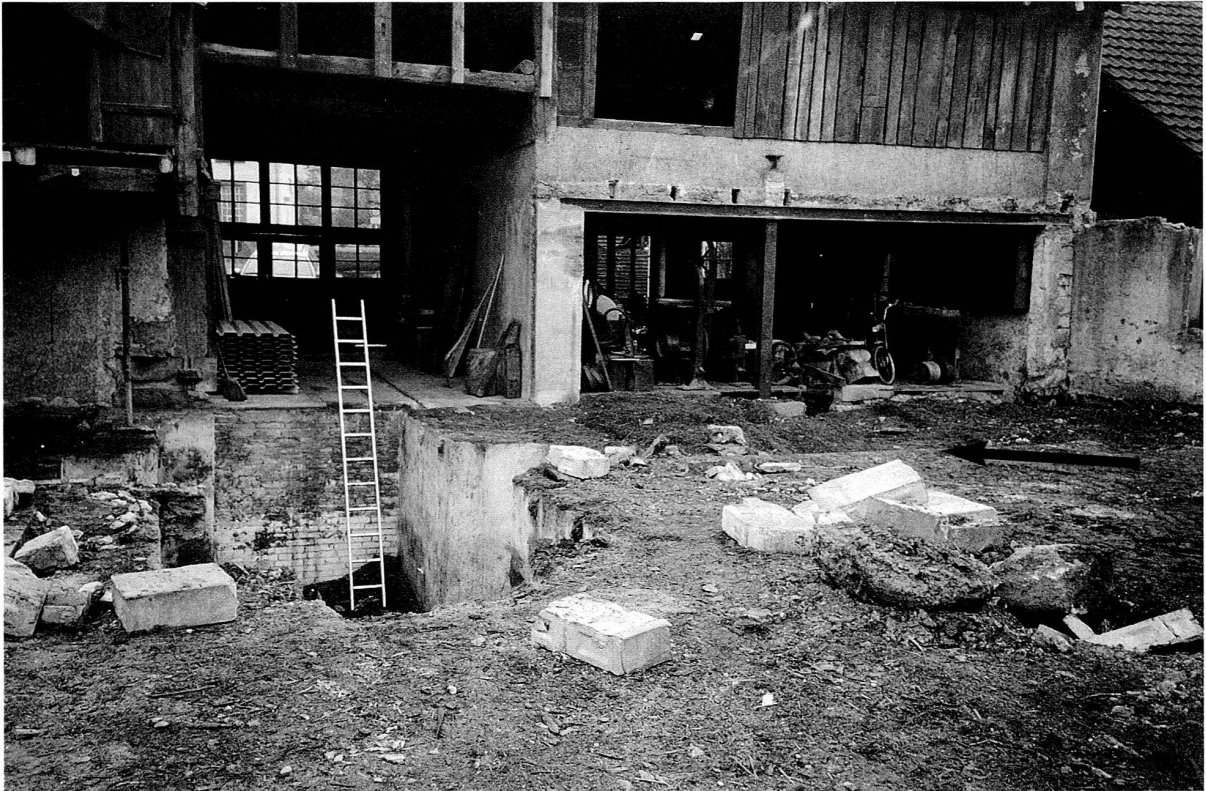
Abb. 8: Augst BL, Sägerei Ruder (Grabung 2002.52). Lage der Gräber (Pfeil) nördlich des teilweise abgebrochenen Sägereitrakts (hinten). Von Norden.
