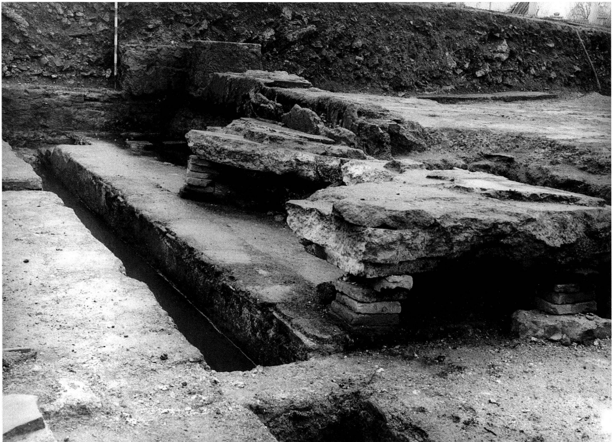
Abb. 15: Augst, BL, Thermenstrasse (Grabung 1937.51). Reste des auf Hypokaustpfeilern ruhenden Beckenbodens mit den Heissluft zuführenden Kanälen. Zustand 1937. Blick von Süden. Beim hinteren Teil des Beckenbodens handelt es sich um das gleiche Stück wie auf Abb. 14.
