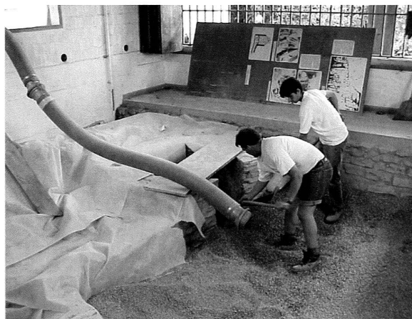
Abb. 51: Augst-Venusstrasse, Töpferei (2002.908). Statt weiter dem Zerfall preiszugeben, wurden die Ofenreste mit Geovlies abgedeckt und mit Feinsplitt zugeschüttet.
