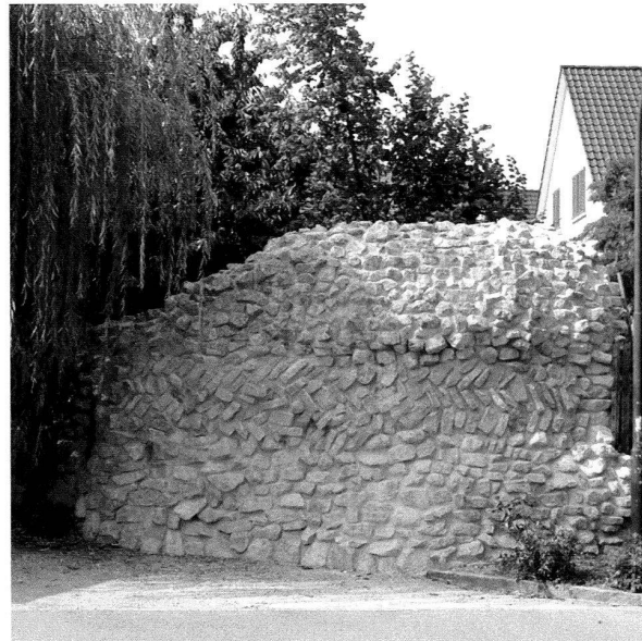
Abb. 48: Kaiseraugst, Kastellmauer am Heidemurweg nach der Neukonservierung (2002.915) und Nachbesserung (2003.915).
