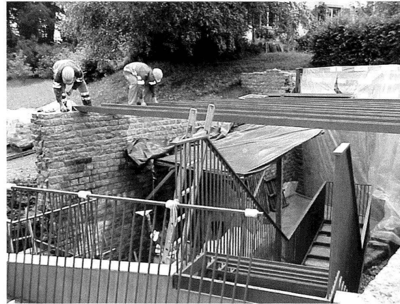
Abb. 41: Augst, Gebäude zwischen der Insula 9 und dem Theater. Konservierung «Bäckerei» und «Wachposten» (2002.907). Montage der Dachträger und des Laufstegs.
