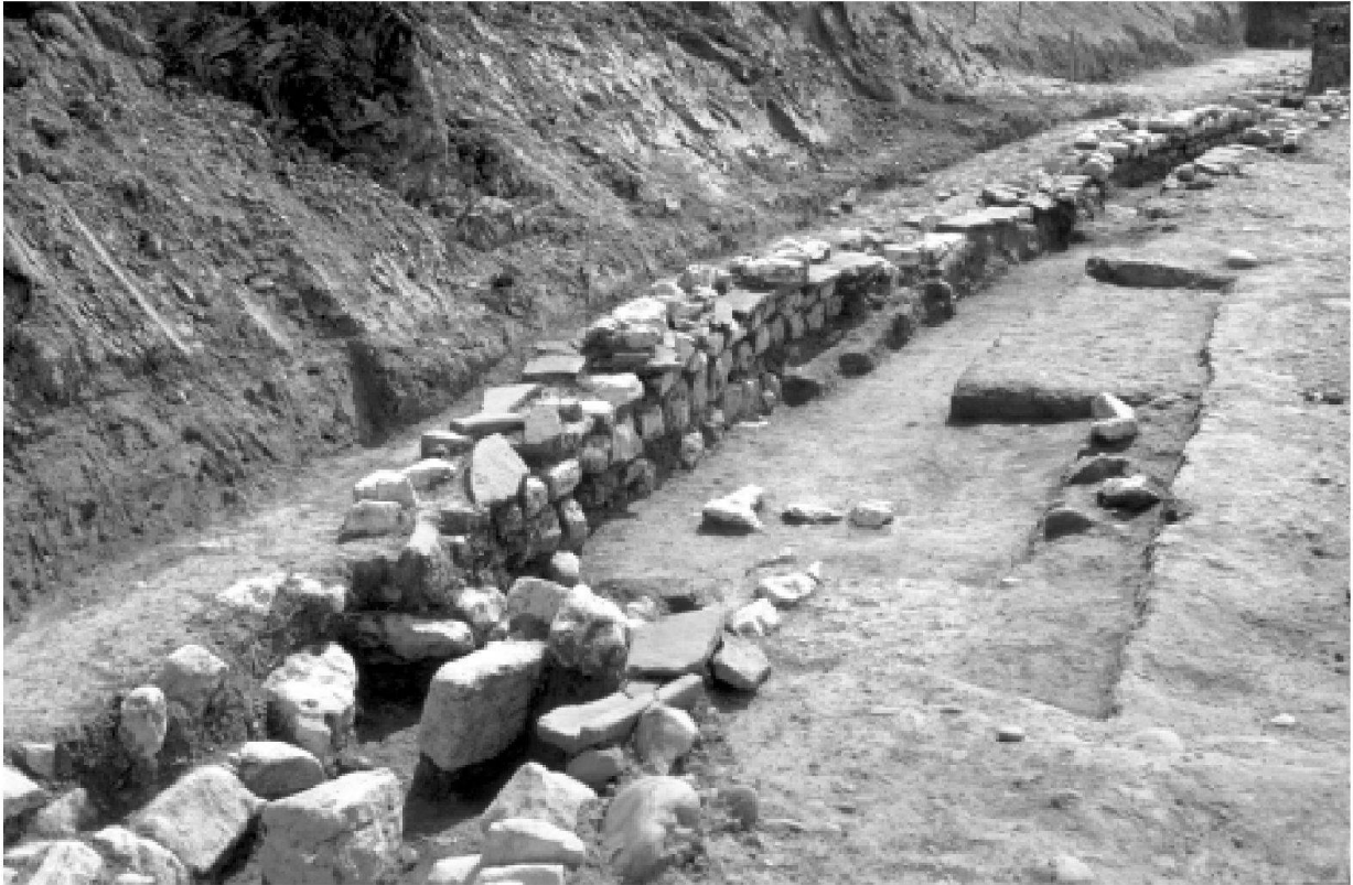
Abb. 7: Kaiseraugst-Hardhof AG. Das beschädigte, vermutlich mit einer Holzleitung reparierte Teilstück des oberen Kanals.
