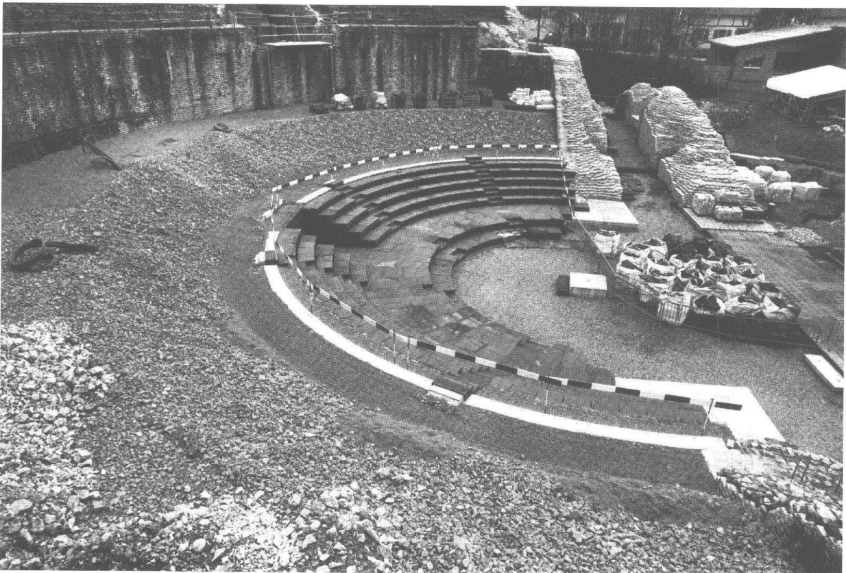
Abb. 30: Augst, Theatersanierung (Grabung 2000.55). Rekonstruktion der Sitzstufen im 1. Rang des Theaters (Abb. 1,B). Stand der Arbeiten nach Beendigung der ersten Ausbauetappe.
