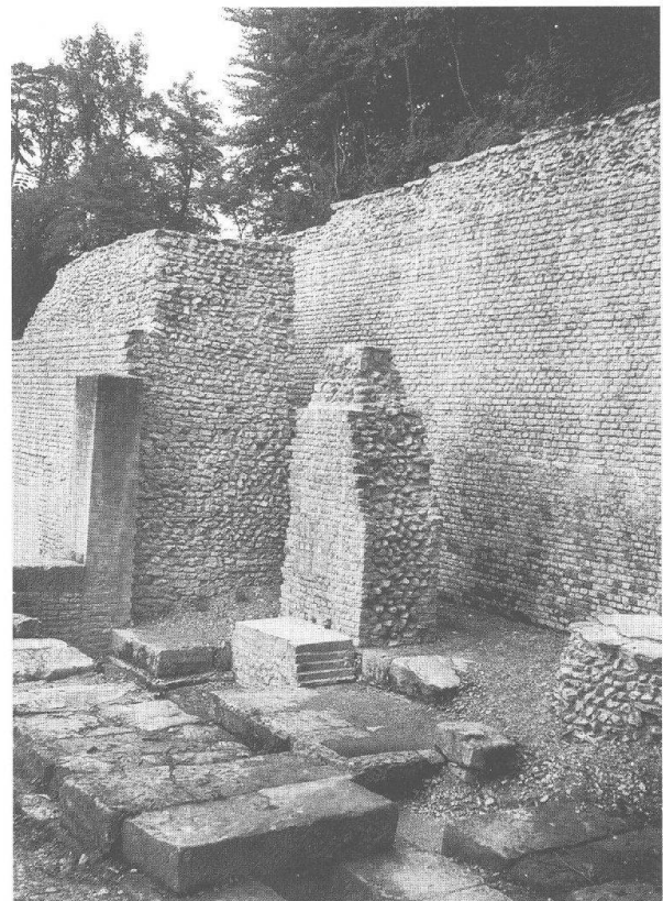
Abb. 32: Augst, Theatersanierung (Grabung 1936.59). Südaditus. Zeitgenössischer Blick auf die 1936 fertig restaurierte innere Bühnenmauer (MR 43) von Süden.
