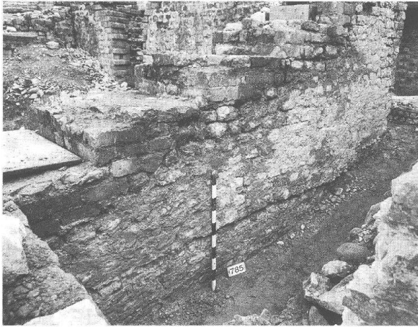
Abb. 13: Augst, Theatersanierung (Grabung 1998.55). Sitzstufen des Amphitheaters und Prohedrie des Ersten Theaters (Abb. 1,3). Blick von Süden an die Rückseite der Carcermauer 26, nach Entfernen der Sitzstufenunterlagen von Abbildung 11 und eines Teils der Füllschichten. Deutlich ist die horizontal verlaufende Baufuge im unteren Bildteil erkennbar.
