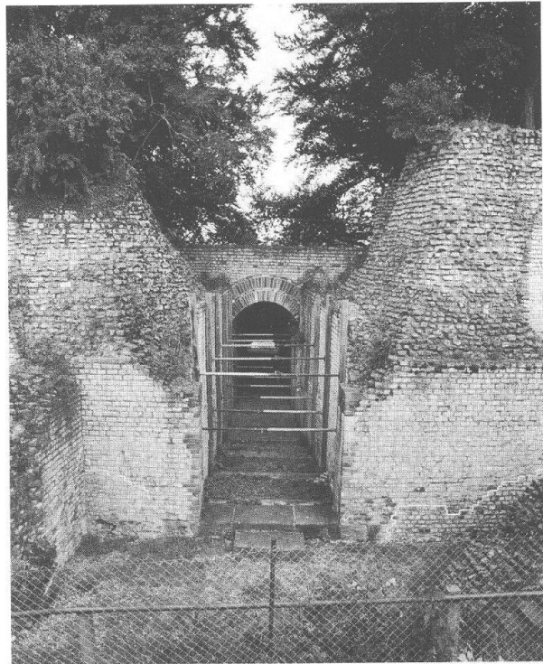
Abb. 24: Augst, Theatersanierung (Grabung 1996.55). Blick von Osten in das Südostvomitorium. Im Vordergrund die um 1939/40 ergänzten, 1992 aus Sicherheitsgründen abgesperrten Wangenmauern. Im Hintergrund die ebenfalls um 1939/40 rekonstruierte Überwölbung aus Stahlbeton und Sandsteinquadern.
