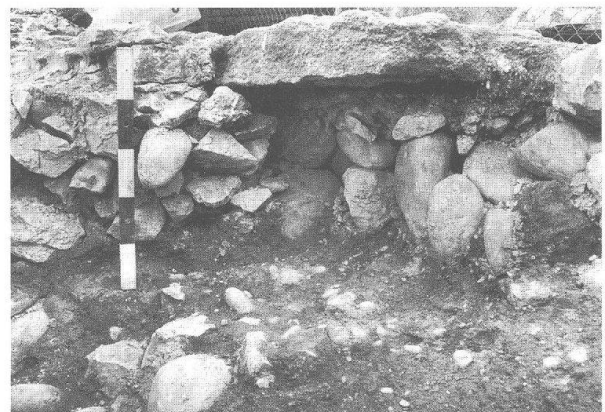
Abb. 12: Augst, Theatersanierung (Grabung 1998.55). Sitzstufen des Amphitheaters und Prohedrie des Ersten Theaters. Kleine Sondierung mit Sitzstufenunterlagen aus Kieselwacken und Kalkbruchsteinen und in situ liegendem Rest eines originalen Sitzstufenquaders aus Buntsandstein (oberer Bildrand).
