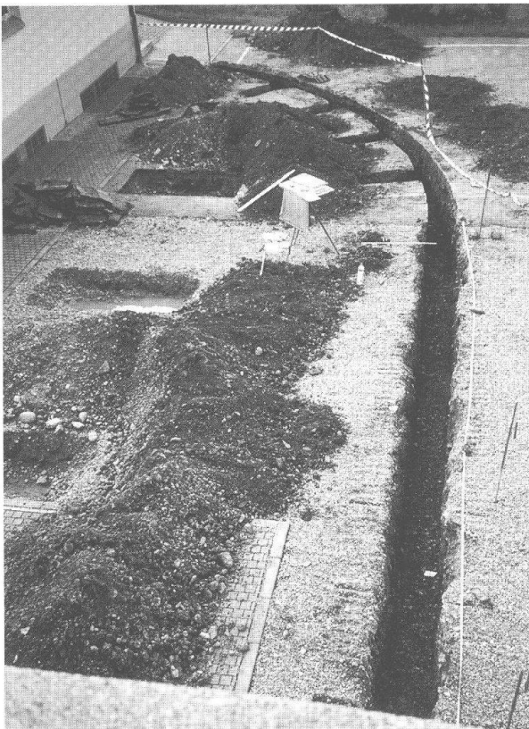
Abb. 12: Augst BL, Region 2,E (Grabung 1998.61). Blick vom 2. Stock des Schulhauses auf den ausgehobenen Fundamentgraben im Pausenplatz. Links oben angeschnitten die Südwestecke der Turnhalle. Von Norden.
