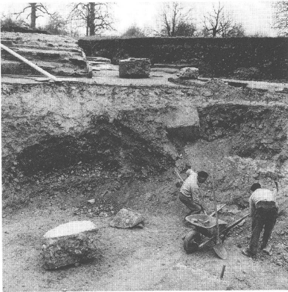
Abb. 3 Augst, Curia (Grabung 1961.60). Das Innere der Curia wird vom Bauschutt befreit – «ausgehöhlt». Das Arbeitsniveau entspricht ungefähr der Oberkante von Schicht 10 in Profil Abbildung 5. Blick von Nordwesten.
