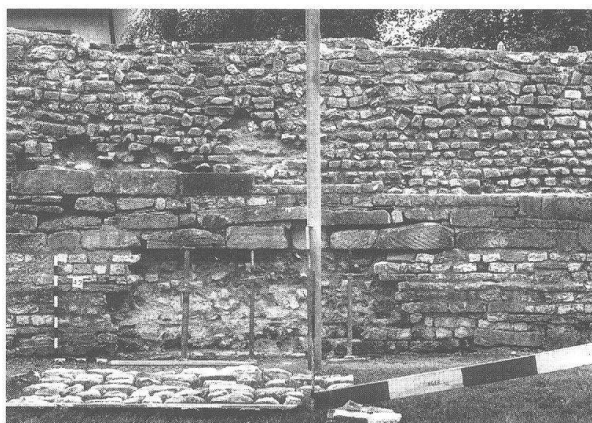
Abb. 3 Kaiseraugst, Sanierung Kastellmauer (Grabung 1994.07). Ausgebaute schadhafte Stelle. Die einzelnen Steinlagen werden stückweise davor deponiert, um danach möglichst mit Originalsubstanz in ursprünglicher Lage eingebaut zu werden.
