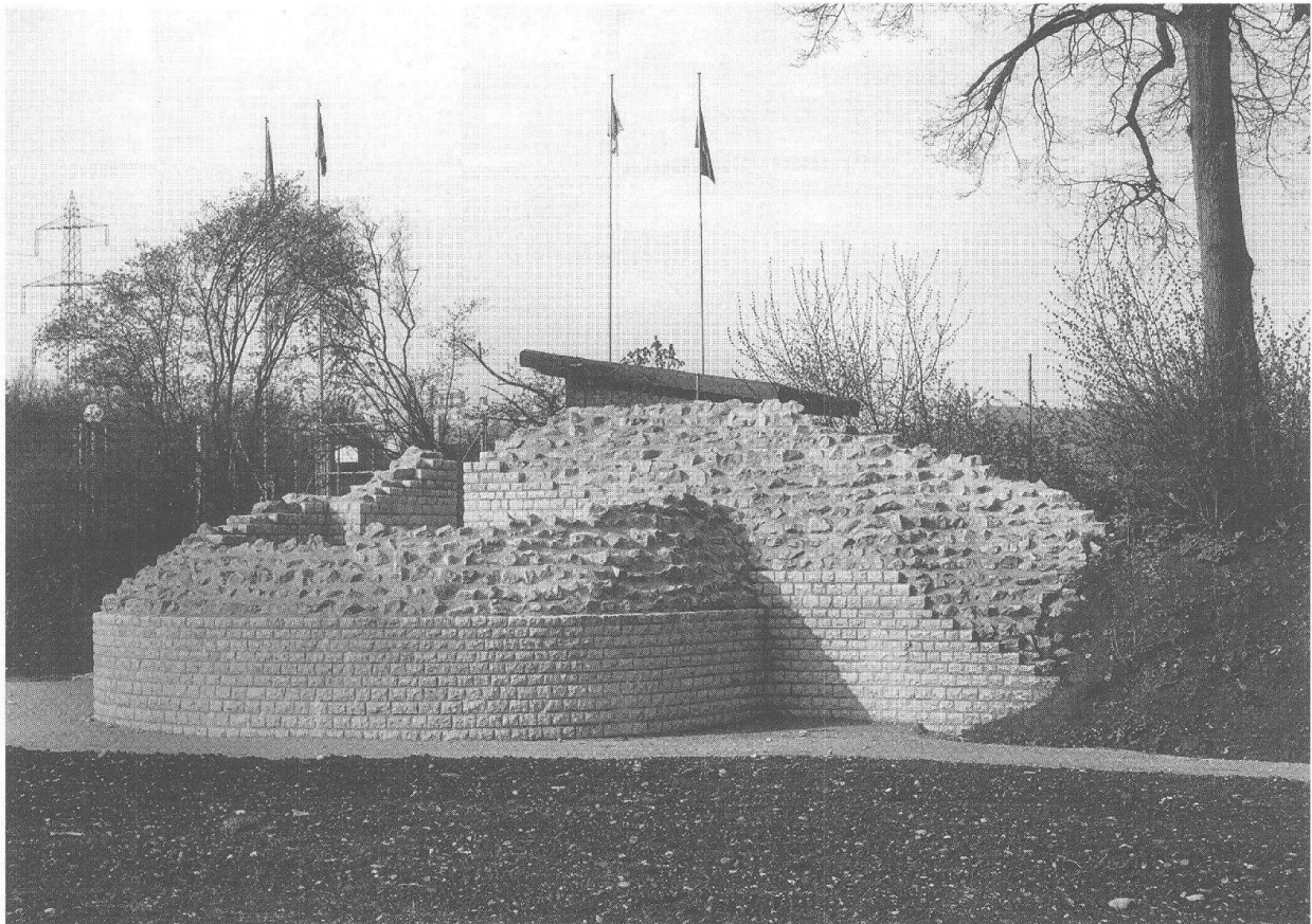
Abb. 12 Augst-Osttor (Grabungen 1993.52 und 1994.52). Die fertig konservierte Anlage mit teilweise wieder aufgebautem halbrundem, an die Stadtmauer angebauten nördlichem Torturm, von Norden (mit Blick ins antike Stadtareal).
