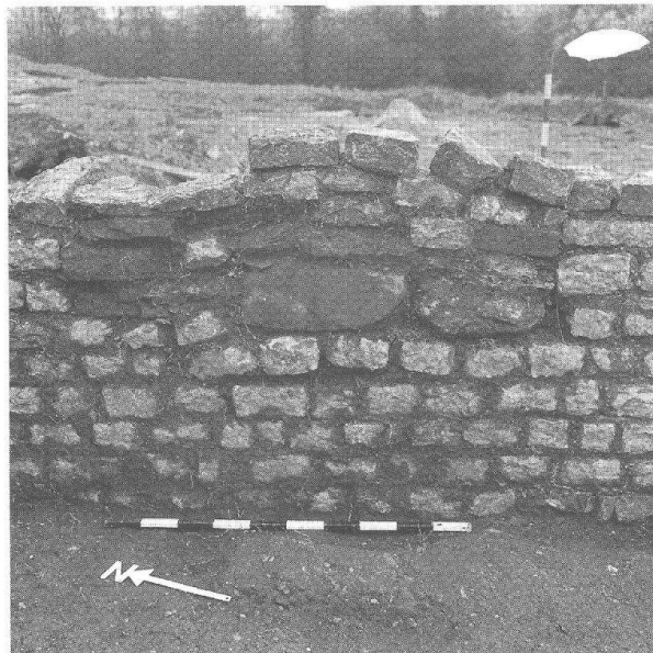
Abb. 30 Augst, Osttor (Grabung 1993.52). Nordteil des Osttores während der Grabung 1966.56. Beachte die unsorgfältig zugemauerte Türe durch die Stadtmauer (Mauer 38) in den Torturm (Mauer 40). Blick gegen Nordosten.
