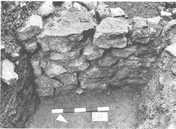
Abb. 15 Augst BL, Grabung 1991.65, Fläche 2. Schrägansicht der Mauer 2 von Osten. Am rechten oberen Bildrand zeichnet sich ein Ausbruch im Mauerwerk ab. Zur Lage vgl. Abb. 13.
