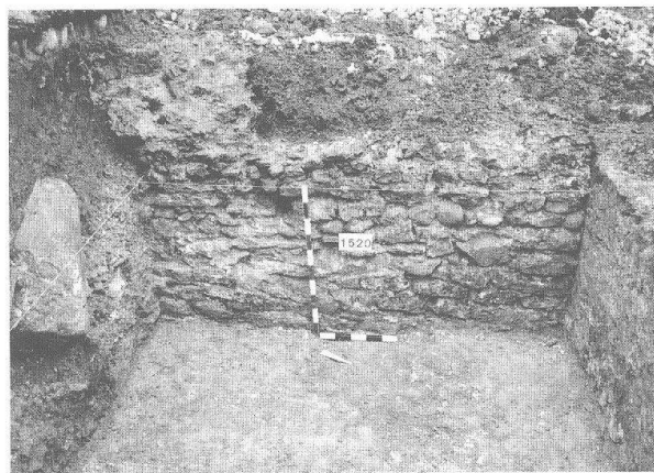
Abb. 23 Kaiseraugst-Hotel Adler 1990.05. Spätmittelalterlicher(?) Keller: Die mittelalterliche Mauer (H16) ist an die römische Kalksteinmauer im Norden angebaut. Links im Profil eine römische Säulentrommel in der Einfüllung. Ansicht von Osten.
