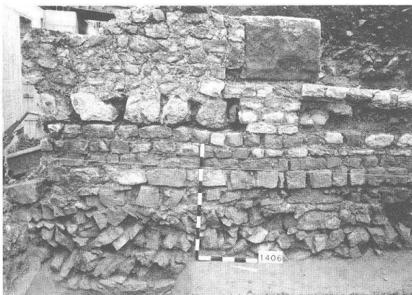
Abb. 15 Kaiseraugst-Hotel Adler 1990.05. Die zwei aufeinanderliegenden Mauern am Westende der Hallenbauten in E12 (Zweiphasigkeit der Steinhauptbauten). Ansicht von Westen.
