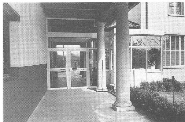
Abb. 10 Der neu erstellte Kassenpavillon zwischen dem Museumsgebäude und der seitlichen Säulenhalle des Römerhauses.
