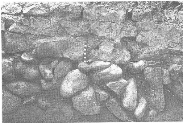
Abb. 28 Augst-Amphitheater 1988. Detail von MR20 mit Kiesel- und Bruchsteinfundament sowie Quadern in pietra rasa -Technik. Blick von Süden.
