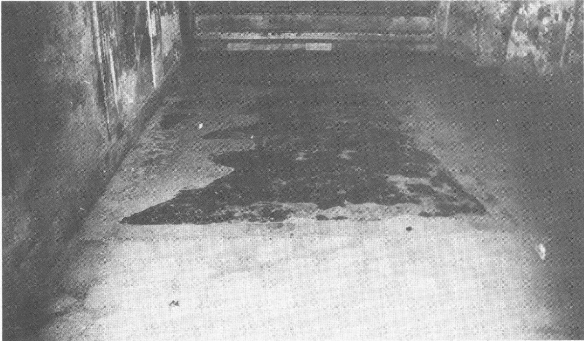
Abb. 8 Pompeji. Forumsthermen, Männercaldarium, Spuren und Umriss der ehemaligen Wanne.
