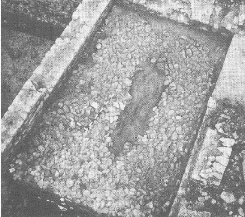
Abb. 12 Augst, Parz. 76.1, Metzger, Schufenholzweg 25. Haus B. Raum an der Nordfront. Unterkonstruktion aus Kalkbruchsteinen nach der Entfernung des darüber liegenden Mörtelgussbodens. Ansicht von Südosten.
