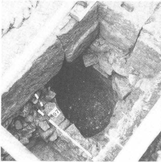
Abb. 53 Kaiseraugst, Parz. 26. Kirchgasse. Detailaufnahme des Mauerwerks wie Abb. 52, erstellt über einem älteren Sodbrunnen.
