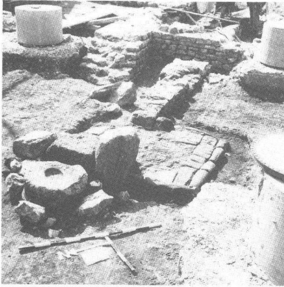
Abb. 21 Augst, Parz. 193/194. Kindergarten. Zwei verschiedene Bauperioden innerhalb des Hauskomplexes Abb. 17; Herdstelle aus Hypokaustziegeln mit Steinen eingefasst, dazu gehörend vorne links ein Galgenstein.
