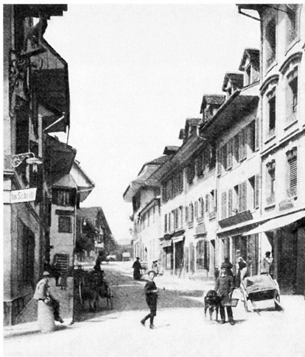
Abb. 53,54 Untere Hauptgasse vor und nach dem Abbruch des Berntors (1876) und den nachfolgenden Neufassadierungen auf dem begradigten Aligement.
