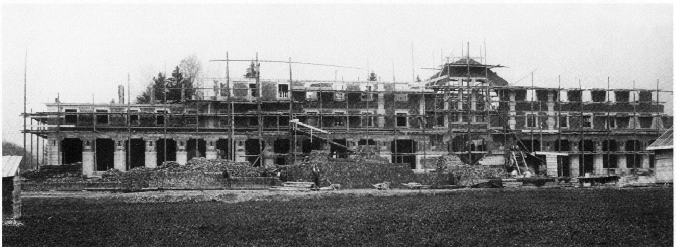
Abb. 40 Der neue Bahnhof (Seestrasse 2) im Bau.
