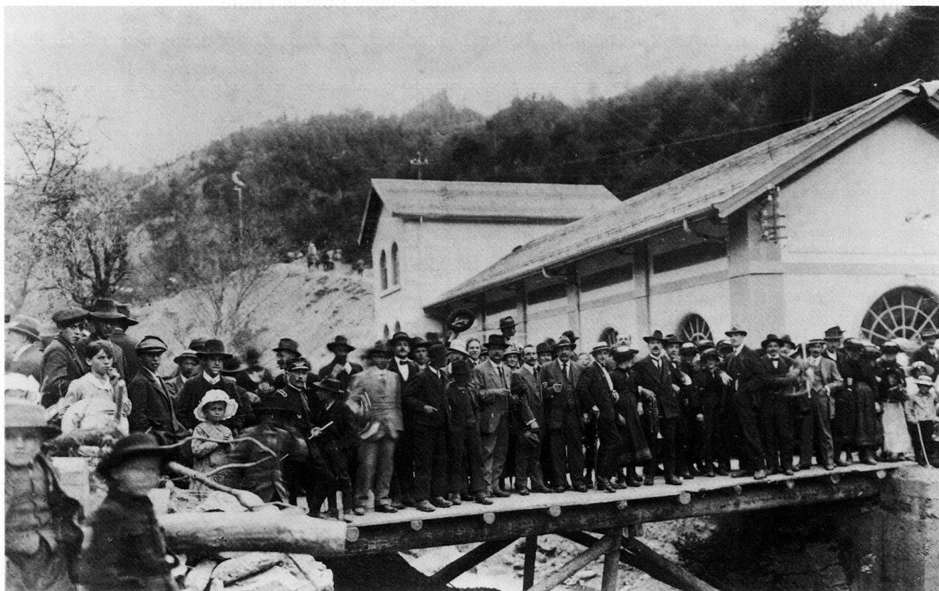
Fig. 8 Inauguration de l'usine électrique de Lienne II le 5 mai 1918.
