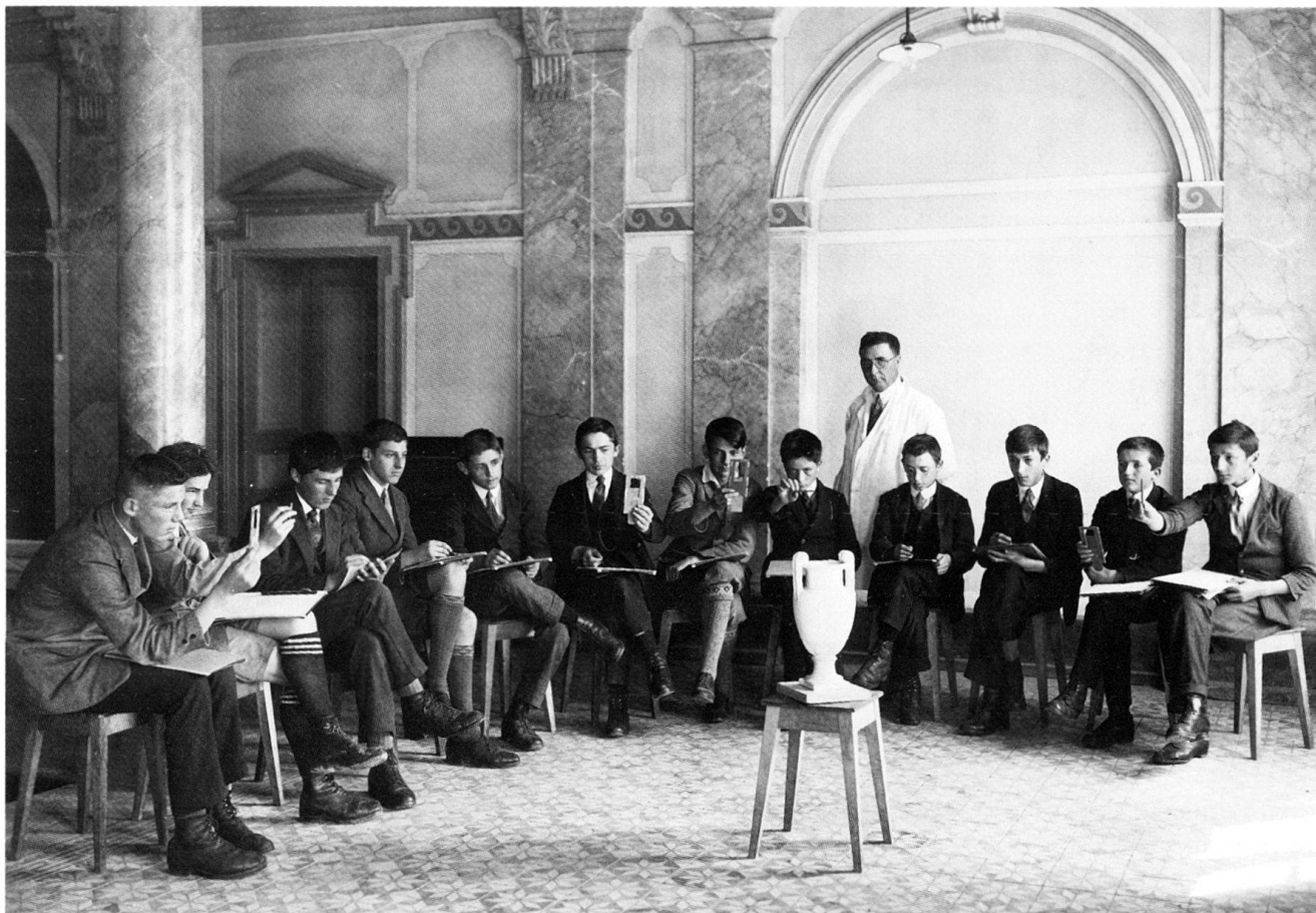
Fig. 17 Classe de dessin donnée par l'architecte Lucien Praz dans le hall du Collège de Sion.
