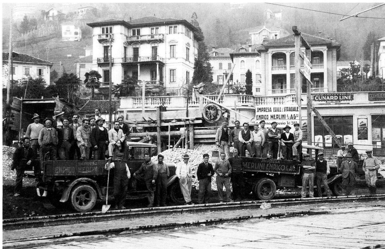
Ill. 13 Locarno–Muralto. Operai edili dell'impresa Merlini durante lavori di pavimentazione in Piazza Stazione. Fotografia del 1930 circa.
