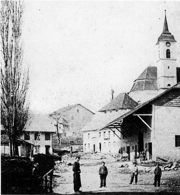
Abb. 39–41 Grenchen. Das Dorfzentrum in Wandlung. – Abb. 39: Die Kath. Kirche vor dem Turmbrand 1868, rechts die Löwenscheune, in der Bildmitte erhöht das Kath. Pfarrhaus und das Rainschulhaus. – Abb. 40: Die am Platz der Zehntenscheune 1860 erbaute Uhrenrohrwerkfabrik von Euseb Girard, links die Kirchstrasse, rechts die Centralstrasse. – Abb. 41: Gleiche Situation wie Abb. 40, in der Mitte das 1896–1898 am Platz der Fabrik erstellte Gebäude des Eidg. Kontrollvereins für Gold- und Silberwaren, das auch als Post- und Gemeindehaus diente (abgebrochen 1953). Photo um 1920. Vgl. Abb. 43.
