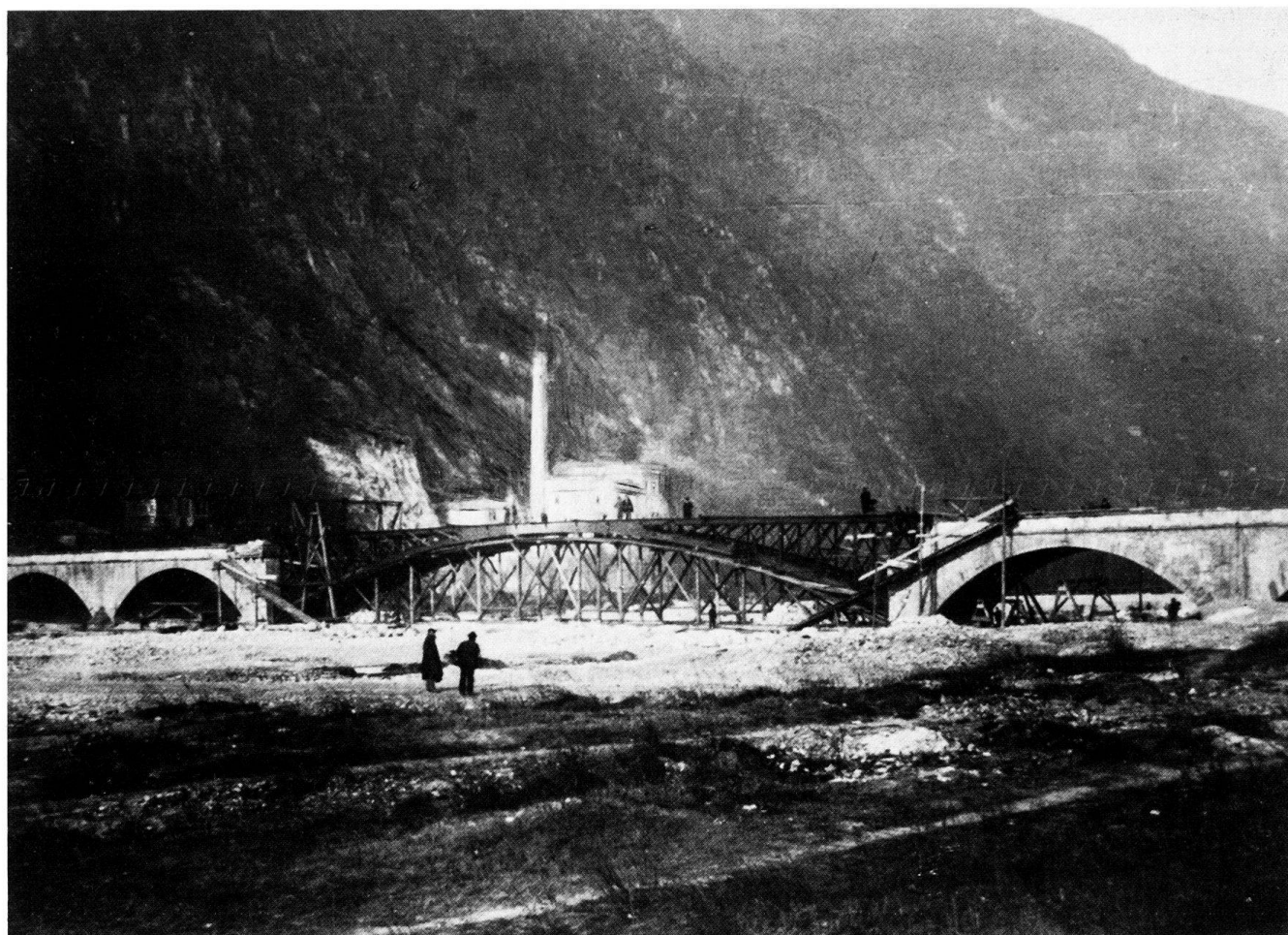
Ill. 30 Bellinzona, Ponte della Torretta, gettato negli anni 1813–1815. Durante i lavori di correzione del fiume Ticino le arcate centrali furono sostituite con un arco in ferro. Sullo sfondo, la ciminiera della Birreria Bonzanigo. Fotografia del 11.1.1901. Vedi ill. 15.
