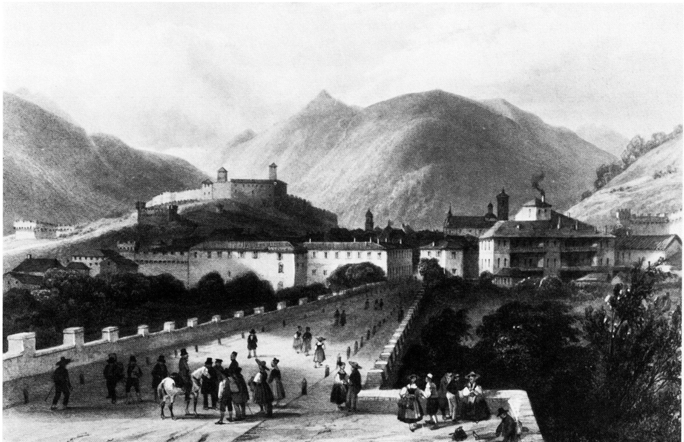
Ill. 16 Bellinzona vista da Sud, litografia a colori di Jean Jacottet e A. Bayot da un disegno di J. Courtin. In primo piano si scorge la strada che collega Giubiasco a Lugano (decreto di costruzione del 1809).
